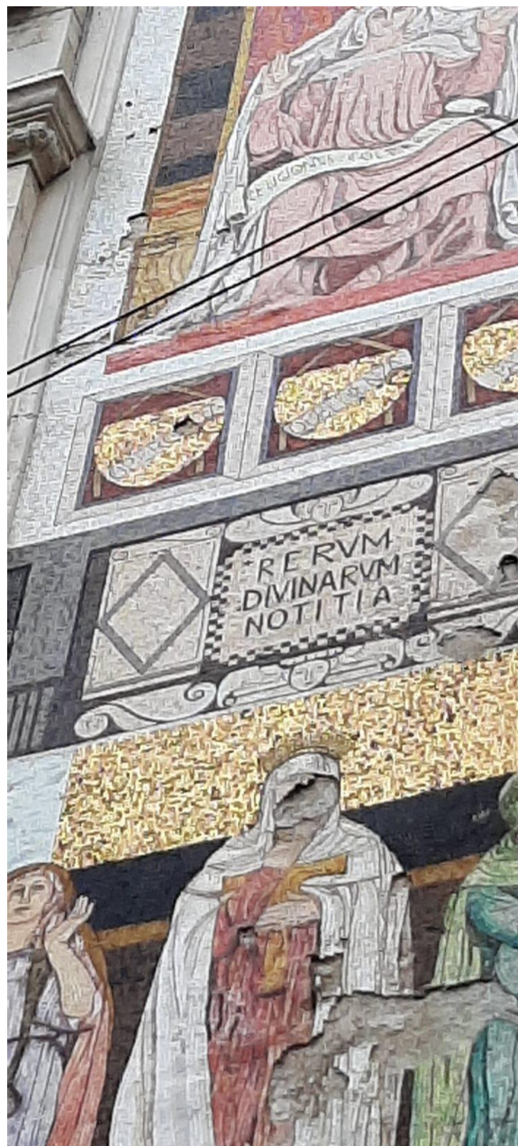
FACCIATA, LATO SINISTROPARTICOLARI DISTACCHI MOSAICO CON LACUNE E PERDITA DI MATERIALE
