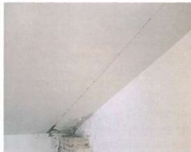
Foto n° 15 – lesione solaio
