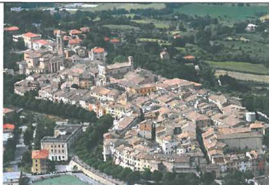
Foto 15 : foto panoramica del Comune estrapolata da web.
