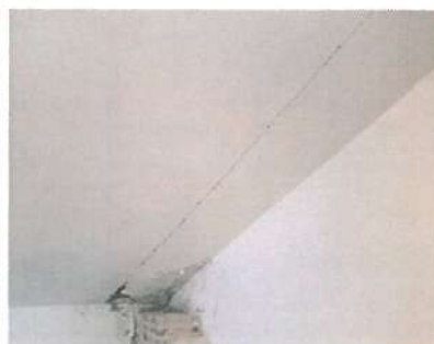
Foto n° 15 - lesione solaio
