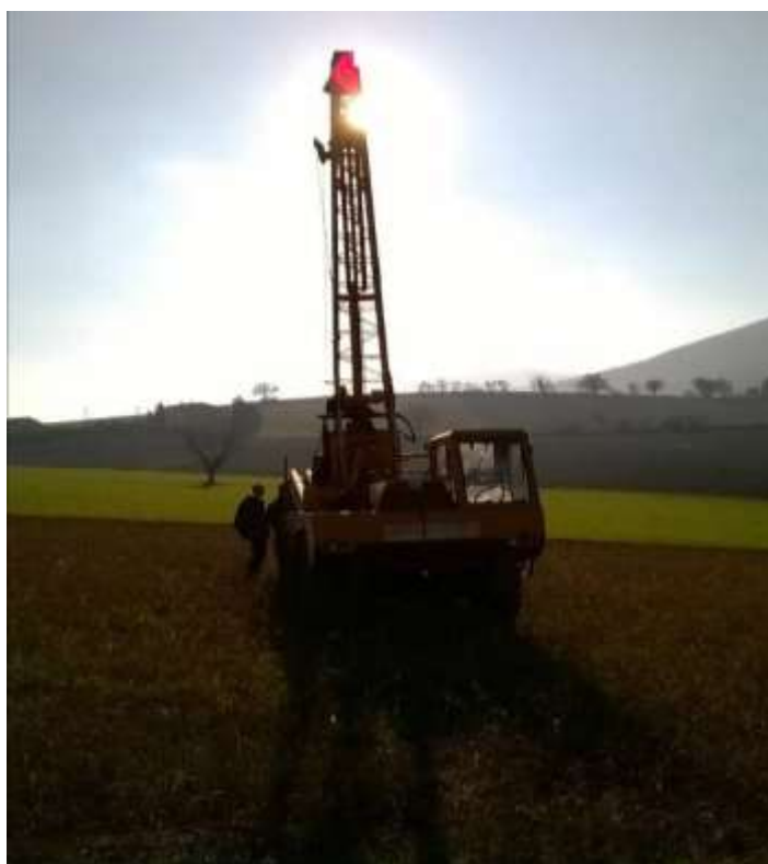
Foto 5 realizzazione sondaggio S2
