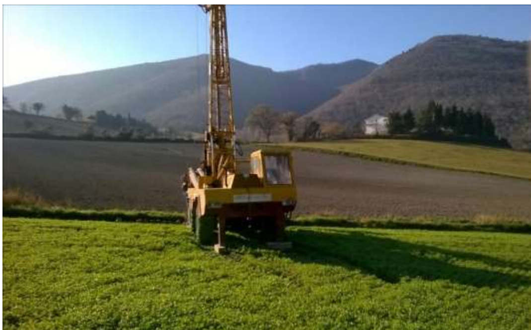
Foto 4 realizzazione sondaggio S1
