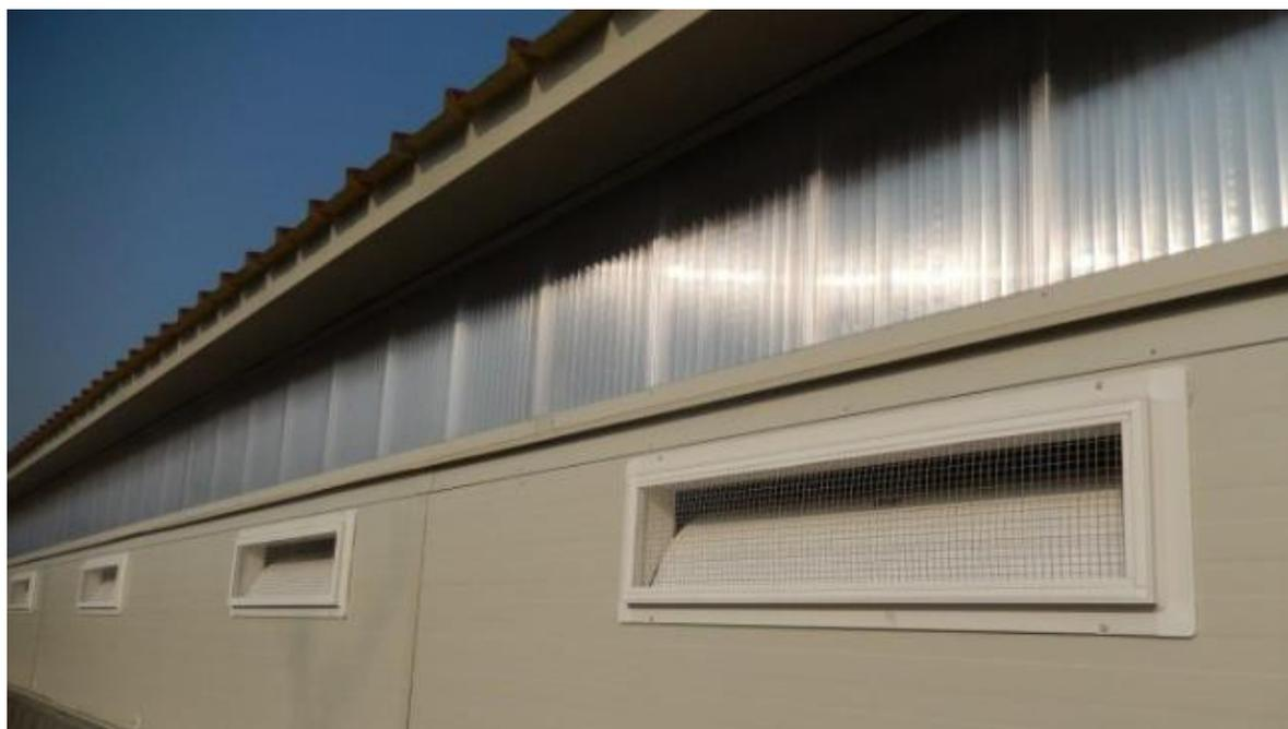
Il tamponamento delle pareti è ottenuto mediante pannelli sandwich spessore mm 100, con K termico di  $0,21 \text{ W/m}^2 \text{ K}$ . I pannelli sono costituiti da due lamiere di supporto ottenute mediante profilatura a freddo di lamiera in acciaio zincato con il sistema Sendzimir e verniciate colore bianco-grigio, spessore mm 0,5.
