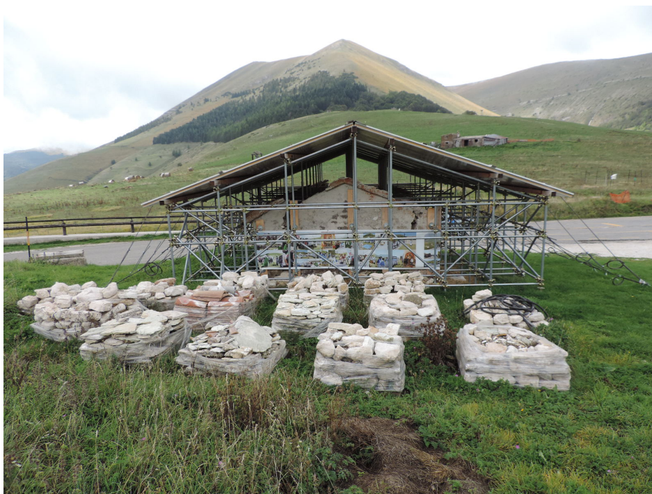
Foto 5: Il contesto dell'area con la tettoia realizzata per la messa in sicurezza del rudere
