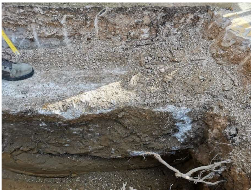
Fig 2. – Sondaggio Fondazione esistente
