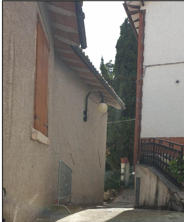
**Foto 9: punto luce a parete tipo da sostituire con lanterna led e braccio artistico**
