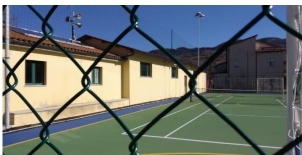
Foto 5b - Edificio polifunzionale - fronte ovest
