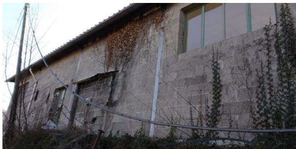
Foto 5a - Edificio polifunzionale - fronte est
