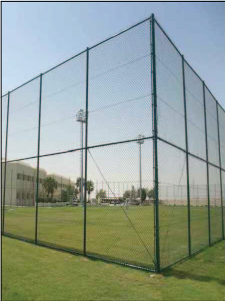
Nuova recinzione perimetrale
