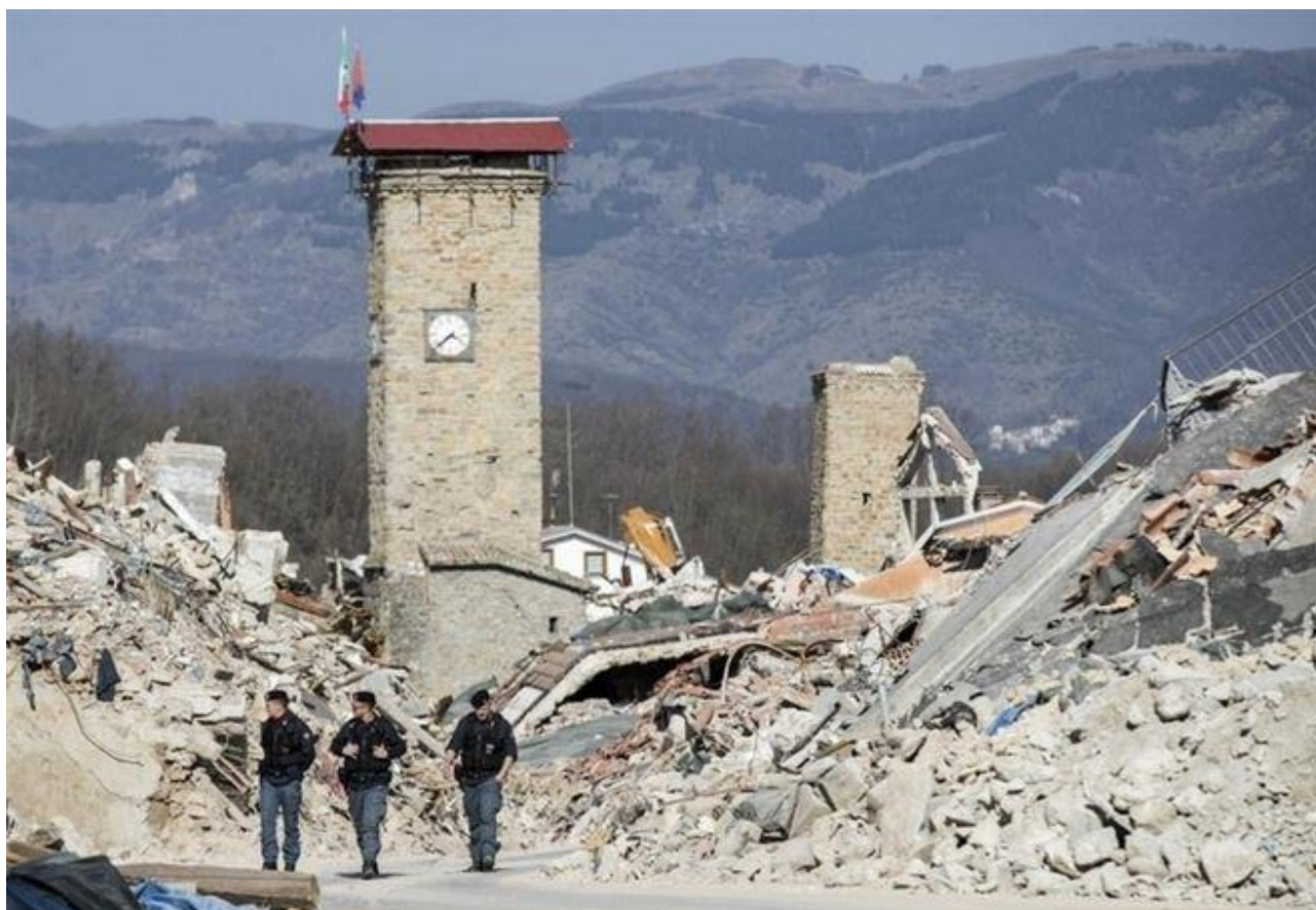
Figura 4 – Un'immagine del post terremoto
