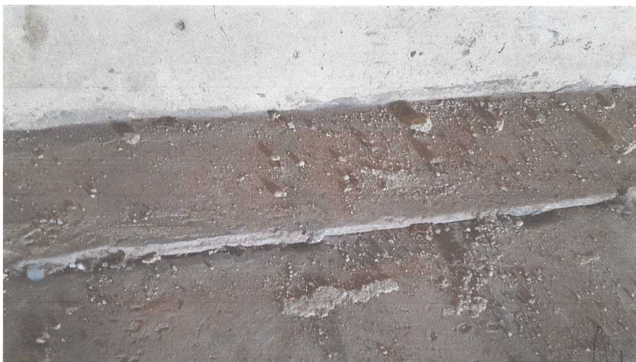
FOTO N. 12 – MOVIMENTO DEL SOLAIO E ROTTURA DELLA PAVIMENTAZIONE
