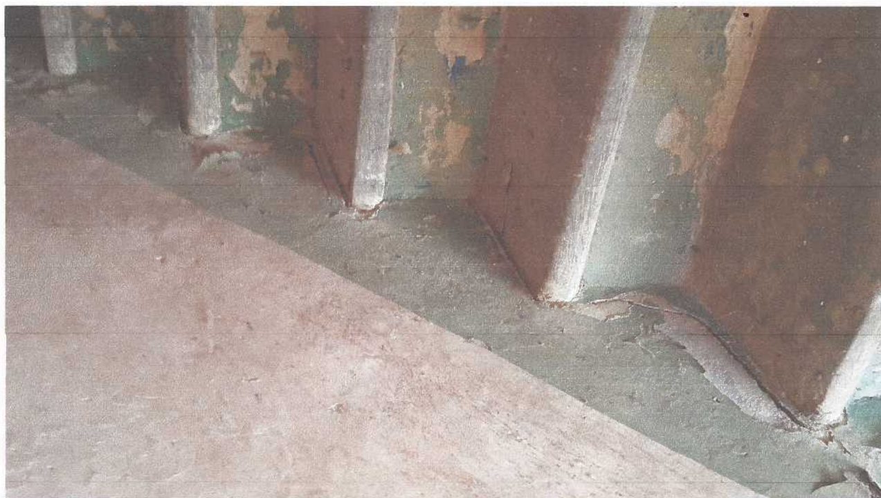
FOTO N. 5 – DISTACCO DELLA SCALA
