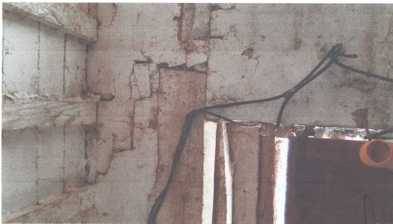
FOTO N. 4 – LESIONE SULLE MURATURE PORTANTI
