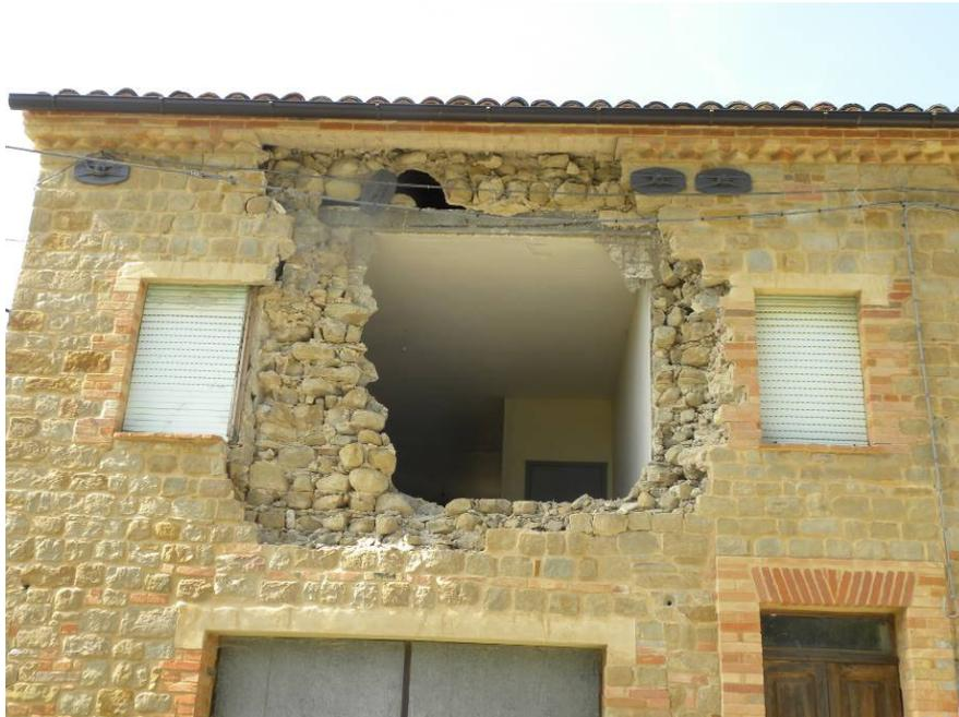
**Figura 6. Espulsione e crollo di muratura**
