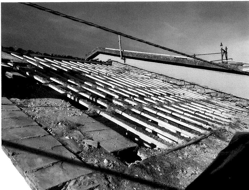
Foto 3 – Smontaggio tetto in legno
