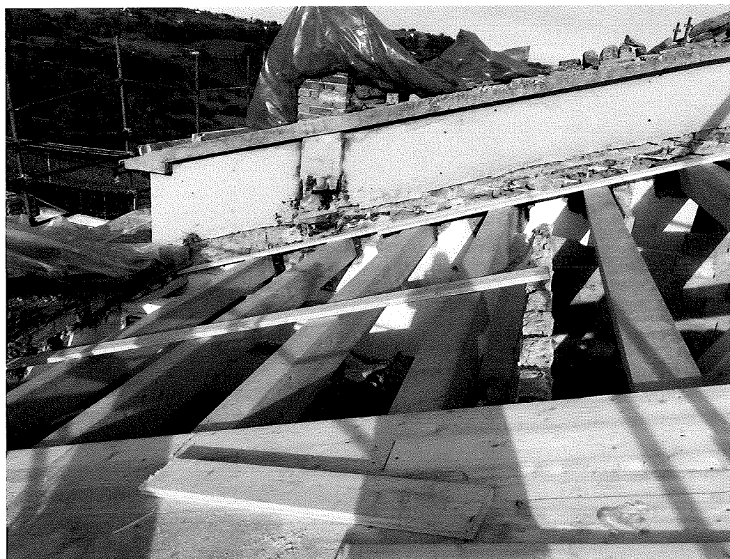
Foto 4 – Montaggio travi in legno
