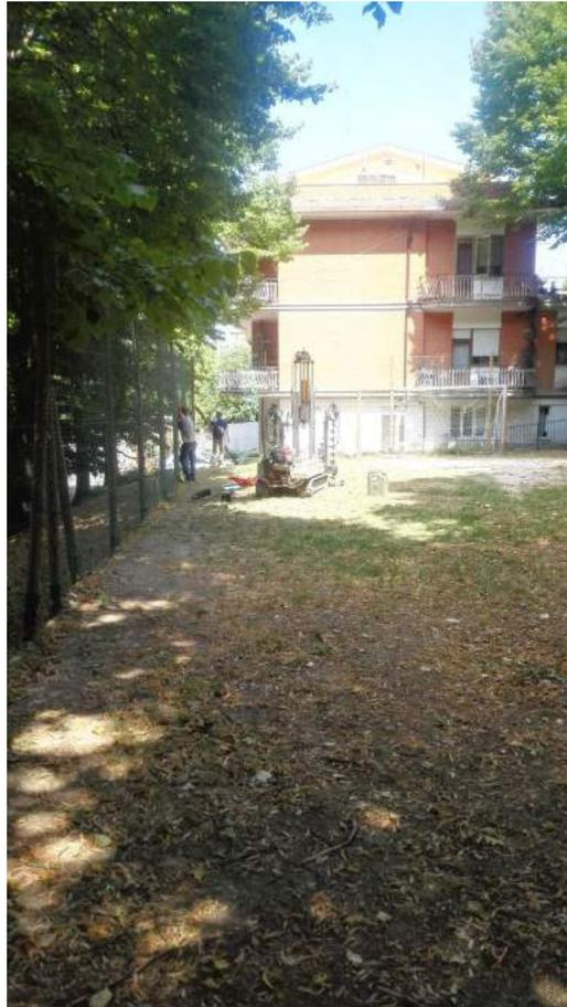
Ubicazione prova penetrometrica dinamica superpesante DPSH 1
