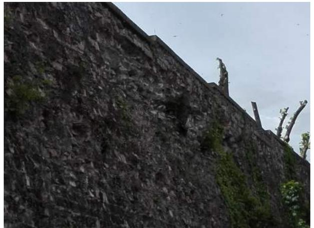
Figura 6 Degradazione del paramento
