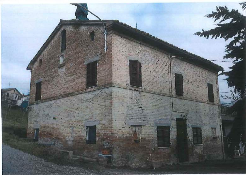
Fronte edificio in oggetto
