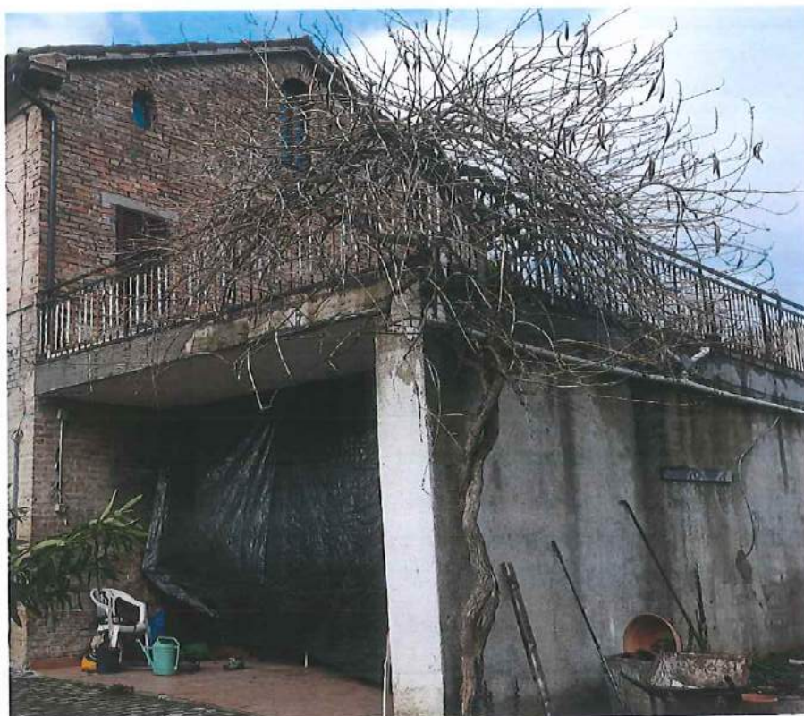
Particolare ampliamento garage realizzato in cemento con copertura piana
