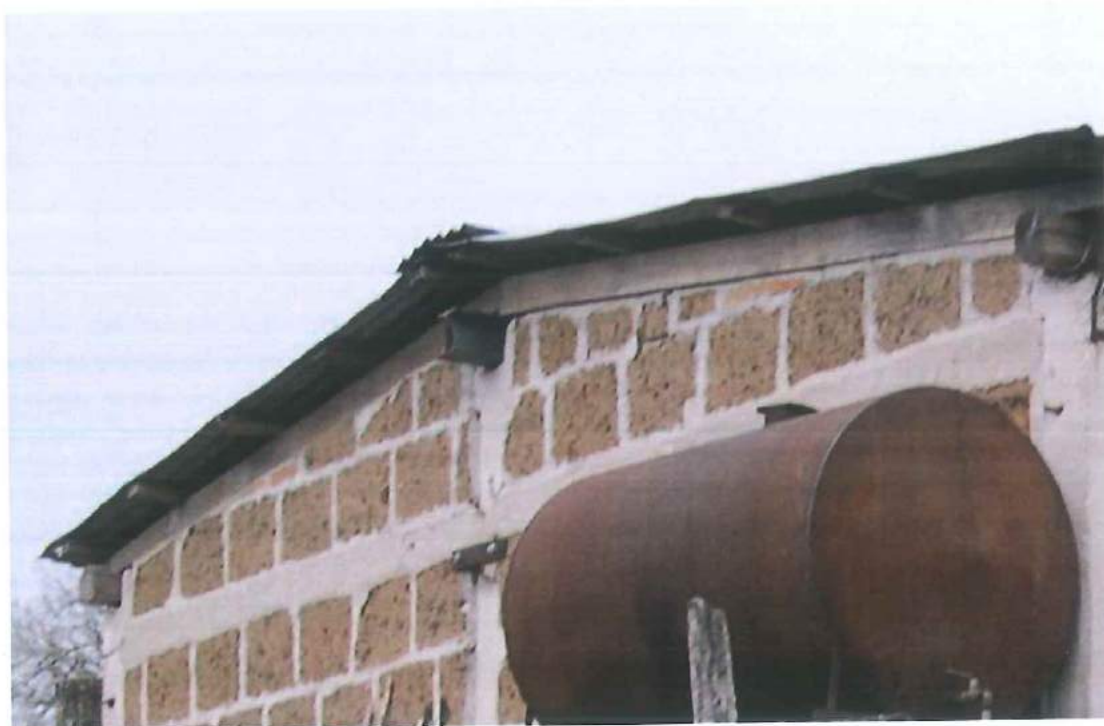
Particolare edificio C con travi d'acciaio e lamiera
