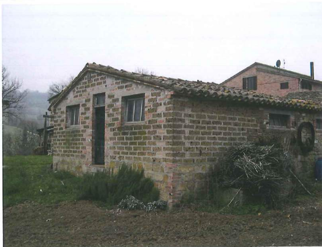
Edificio B particolare ampliamento con muratura in blocchi di tufo.
