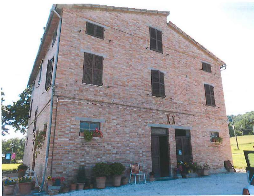
Edificio A composto da n.3 piani furi terra, con mattoni a faccia vista non a mano
