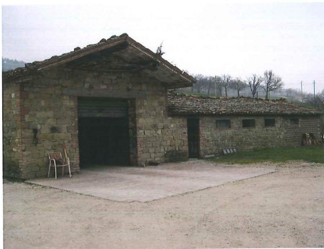
Edificio B, muratura portante in pietra e mattoni
