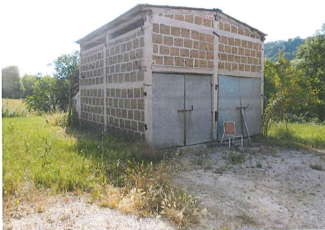
Edificio C , muratura portante in blocchi di tufo e pilastri in c.a.
