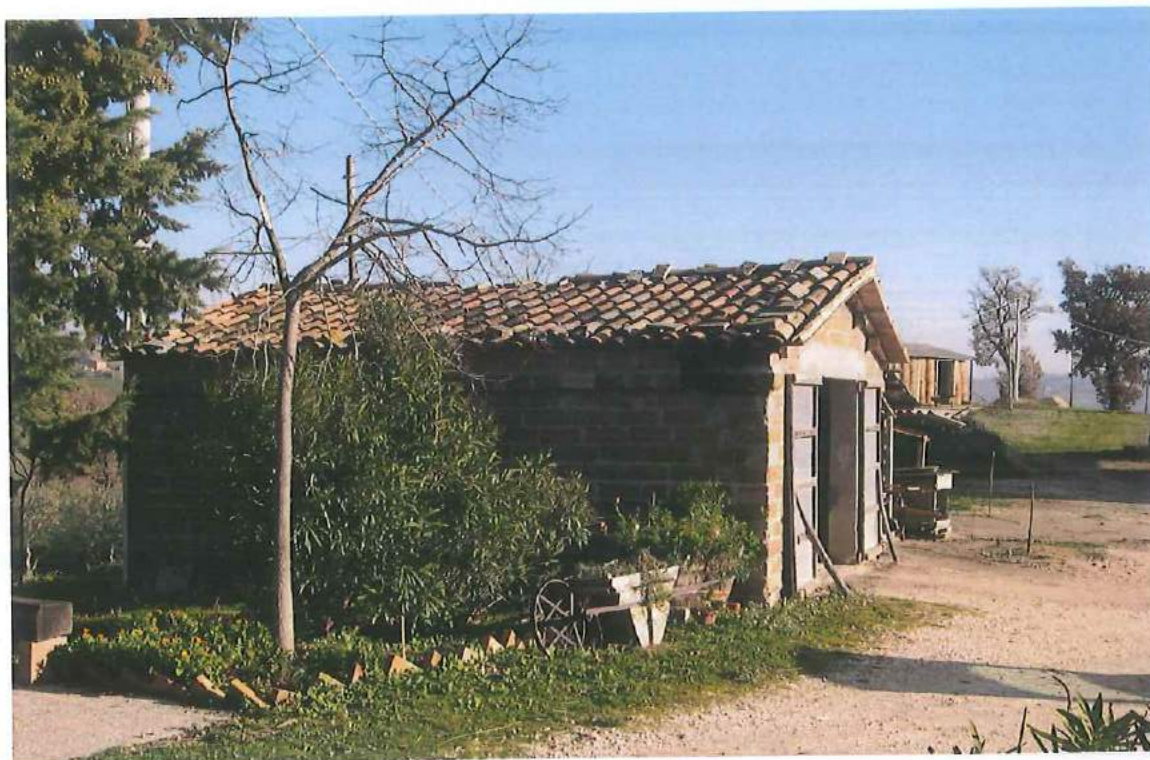
Edificio E realizzato in blocchi di tufo
