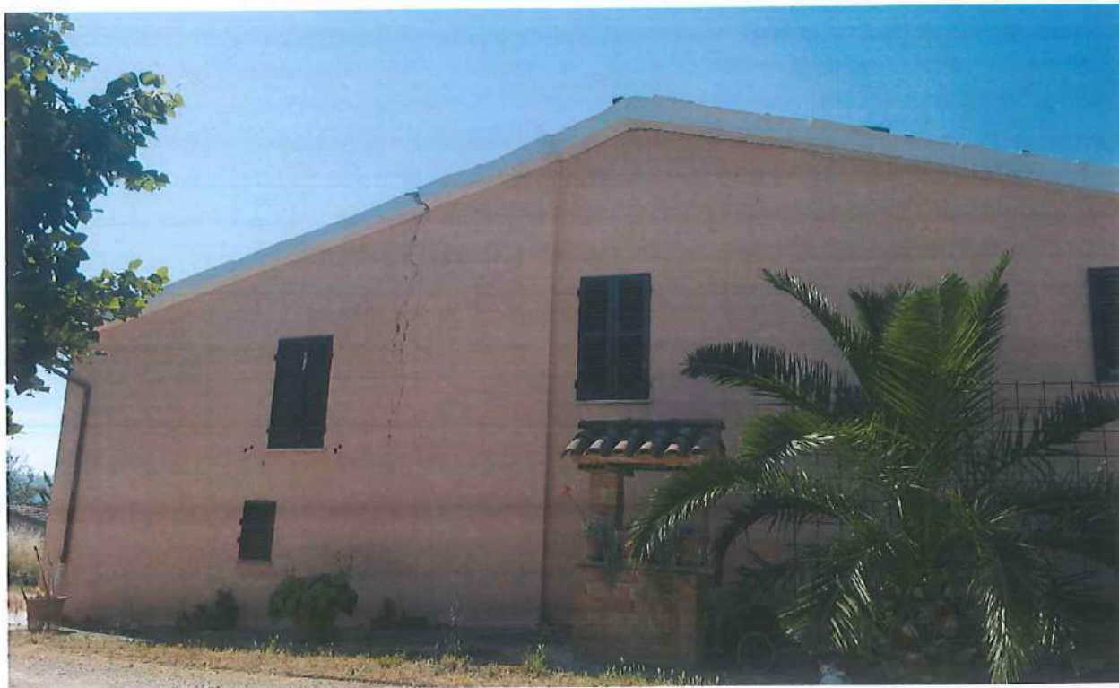
Particolare copertura in latero-cemento
