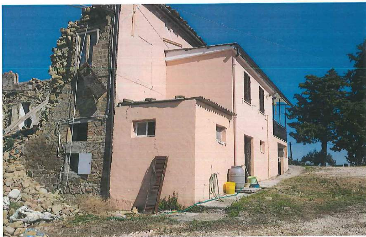
Particolare parziale intonacatura e copertura in lamiera.
