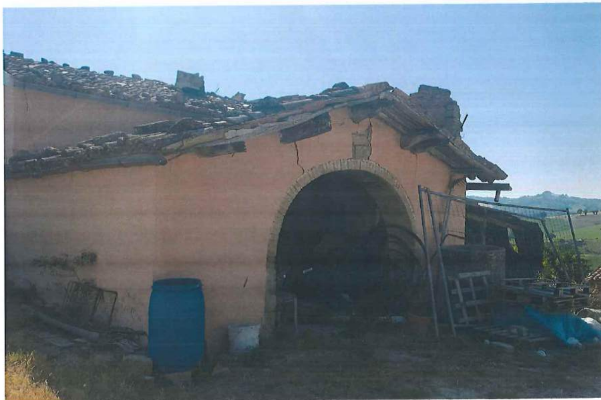
Particolare copertura in travi di legno.
