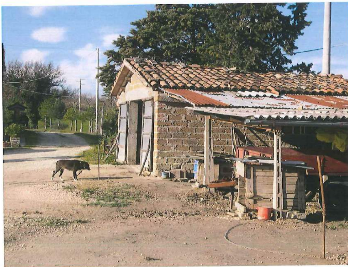
Particolare tettoia realizzata con pali di cemento e lamiera
