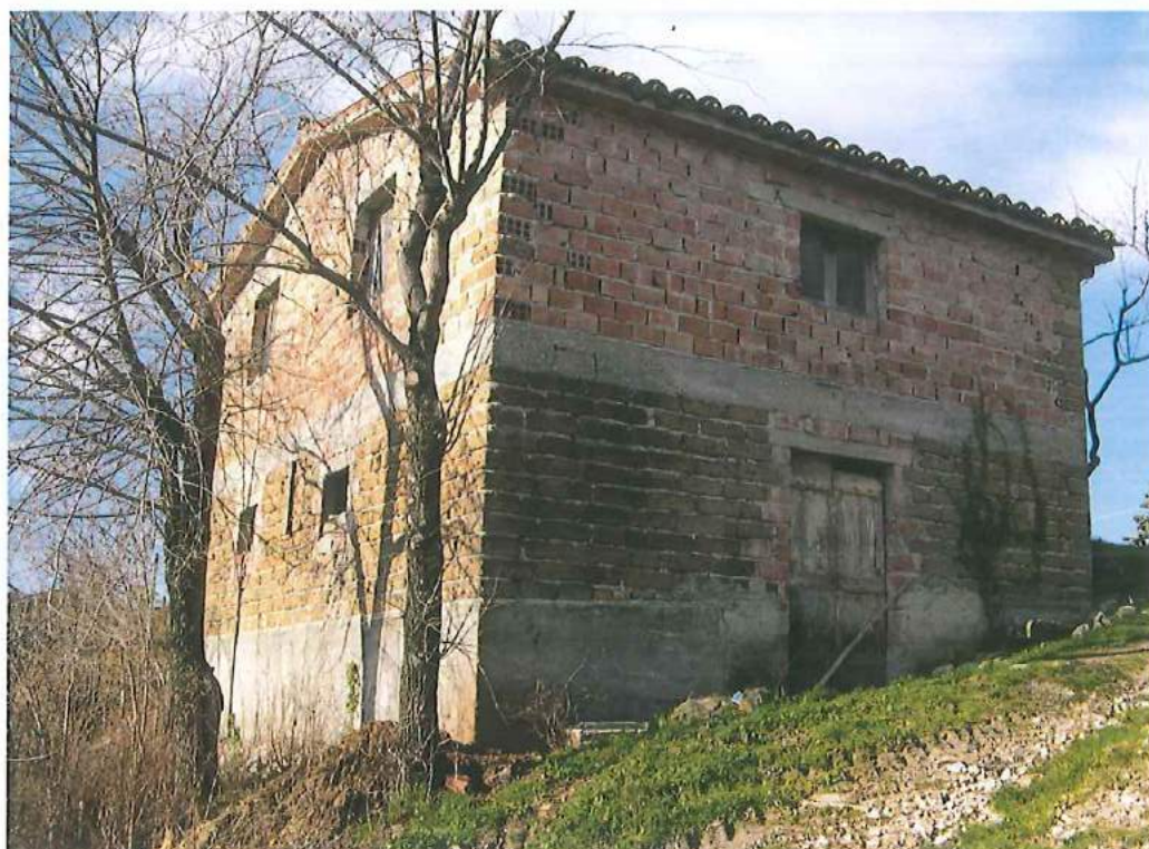
Particolare edificio C realizzato in blocchi di tufo sotto e sopra in blocchi di laterizio con solai in latro cemento
