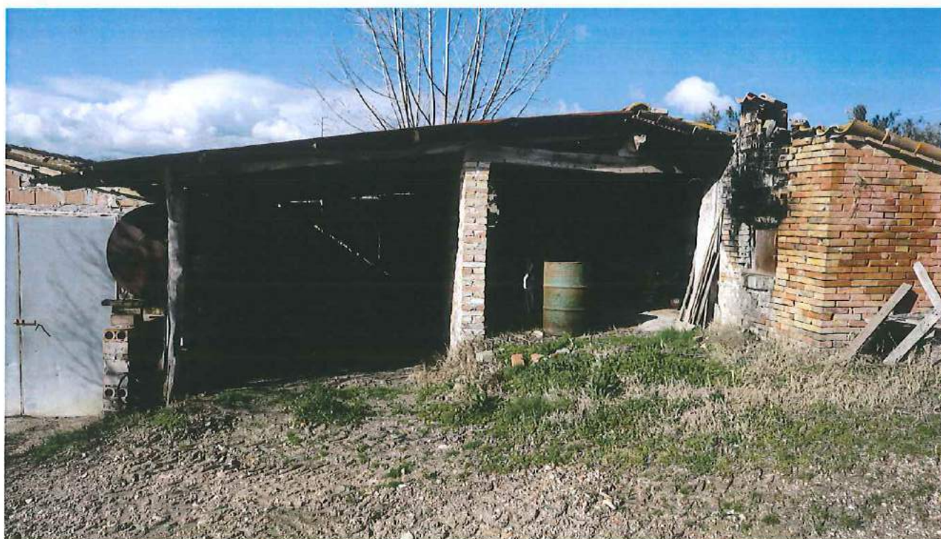
Edificio D prima dei lavori
