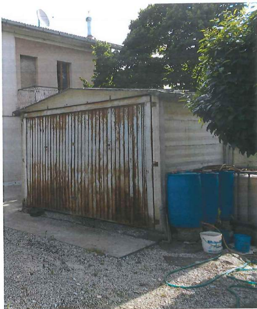
Accessorio realizzato in pannelli di cemento prefabbricato
