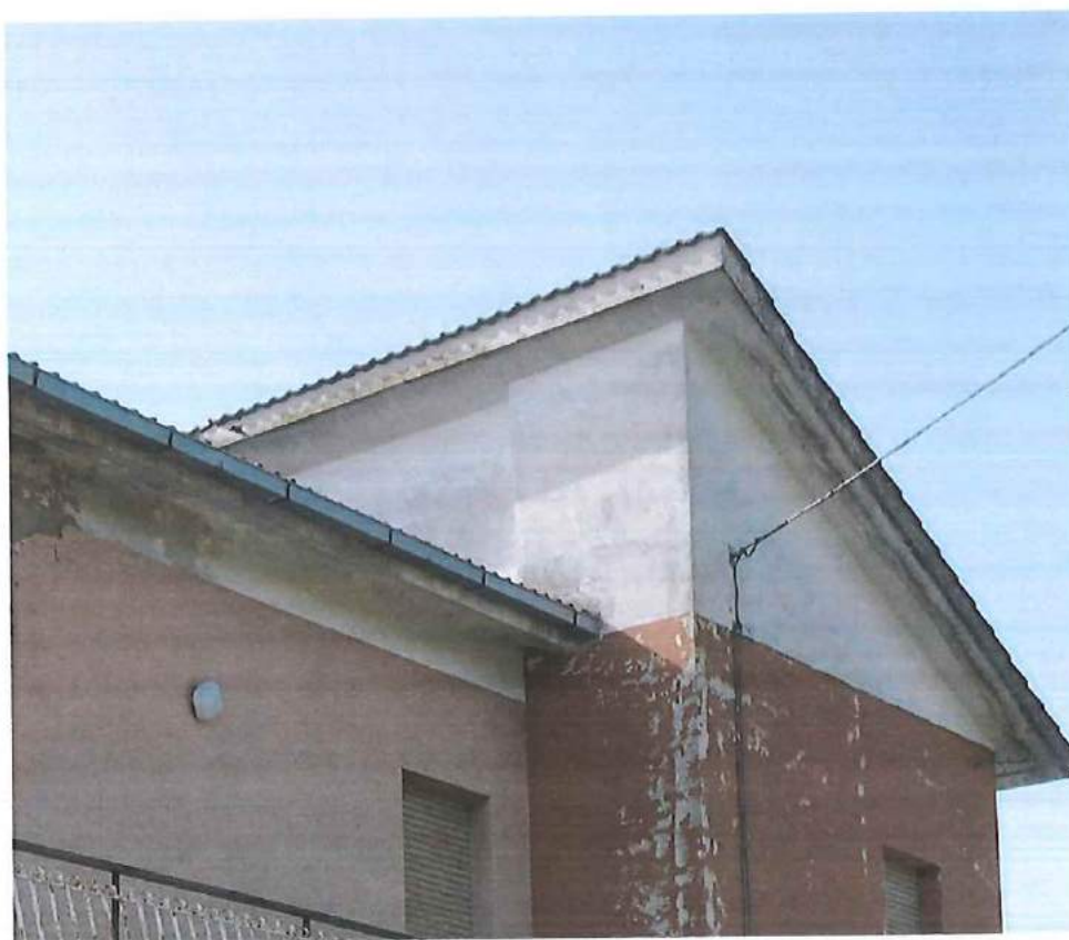
Particolare cornicioni in cemento e falde di copertura sfalsate.
