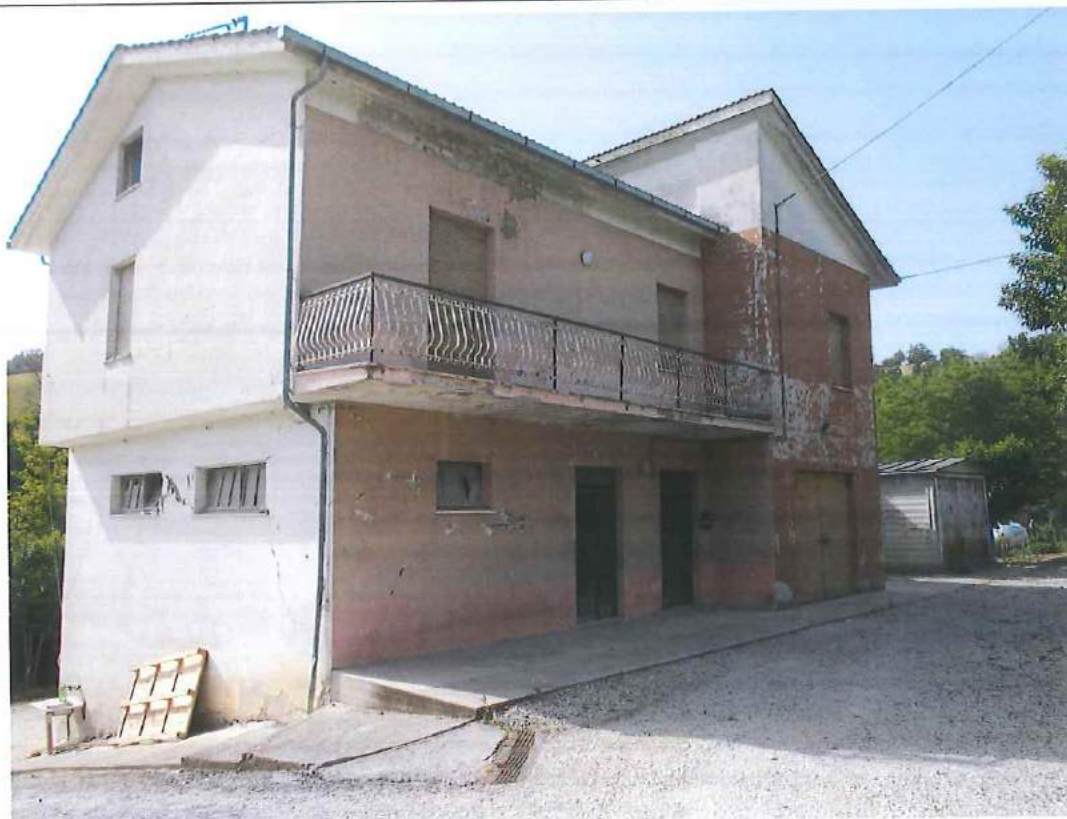
Prospetto ovest, n.3 piani furi terra, intonaci di diverso colore, tapparelle in PVC e balconi in cemento
