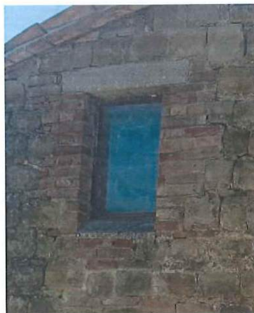
Particolare delle aperture edificio A , con architrave in cemento e cornici in mattoni faccia vista
