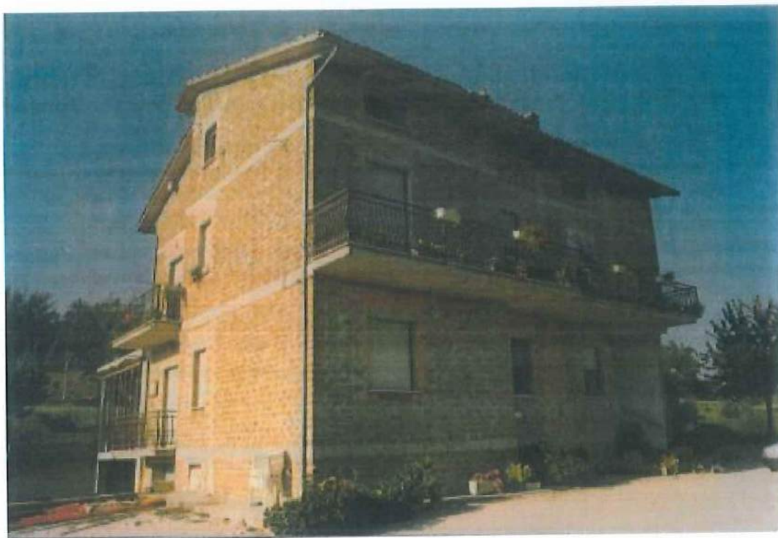
Edificio B realizzato in blocchi di tufo e c.a.
