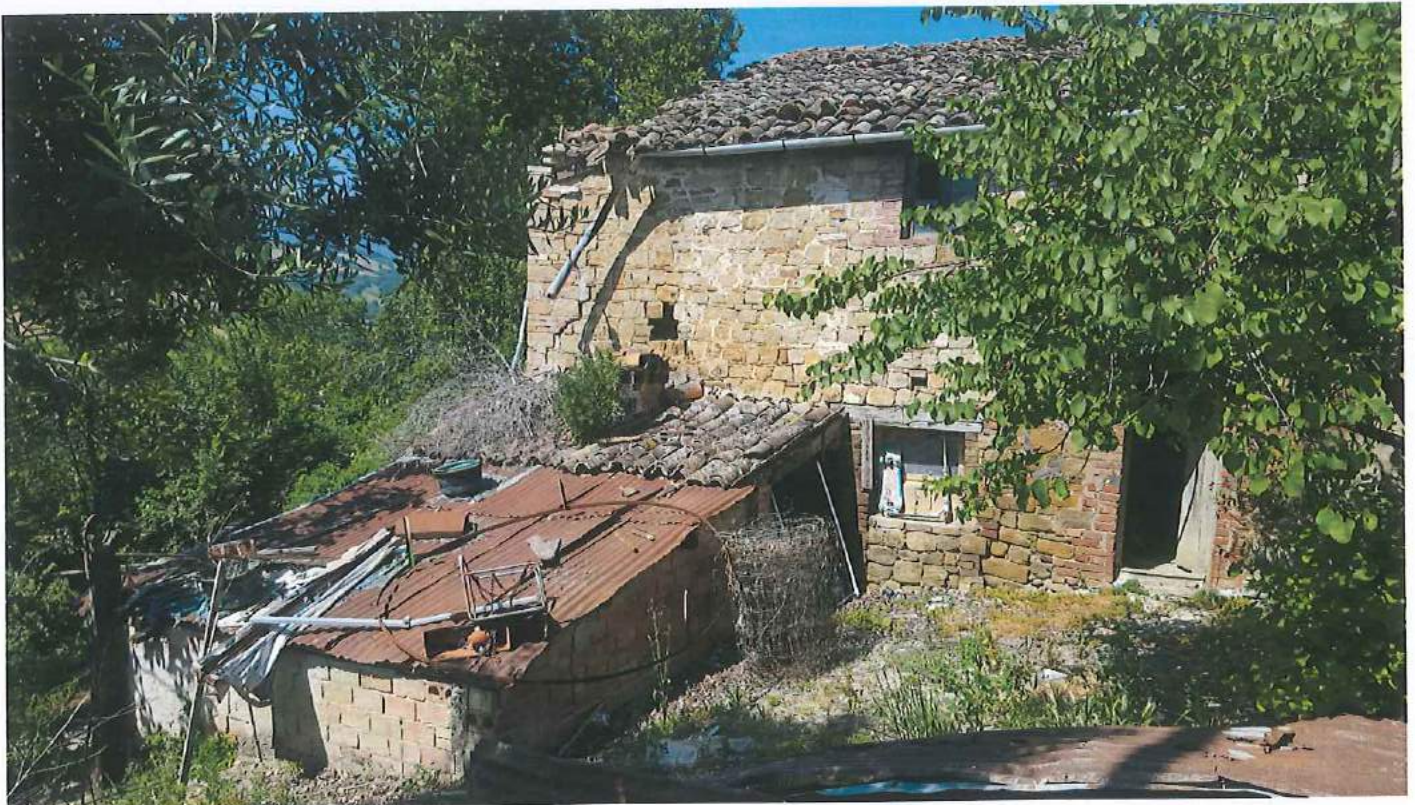
Particolare edificio A , ampliamento con copertura in lamiera
