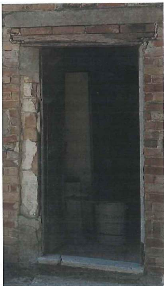
Particolare delle aperture edificio A , con architrave in cemento e cornici in mattoni faccia vista
