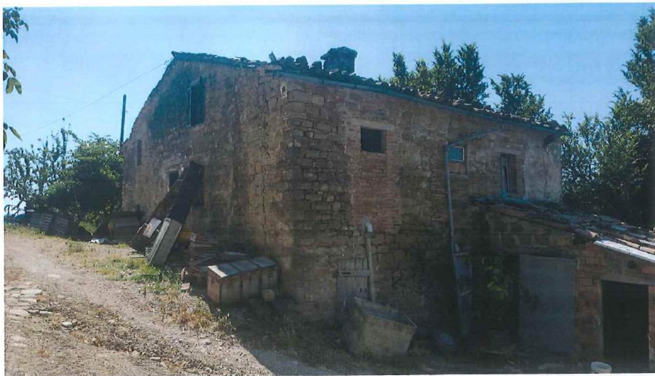
Edificio A , particolare degli ampliamenti subiti negli anni
