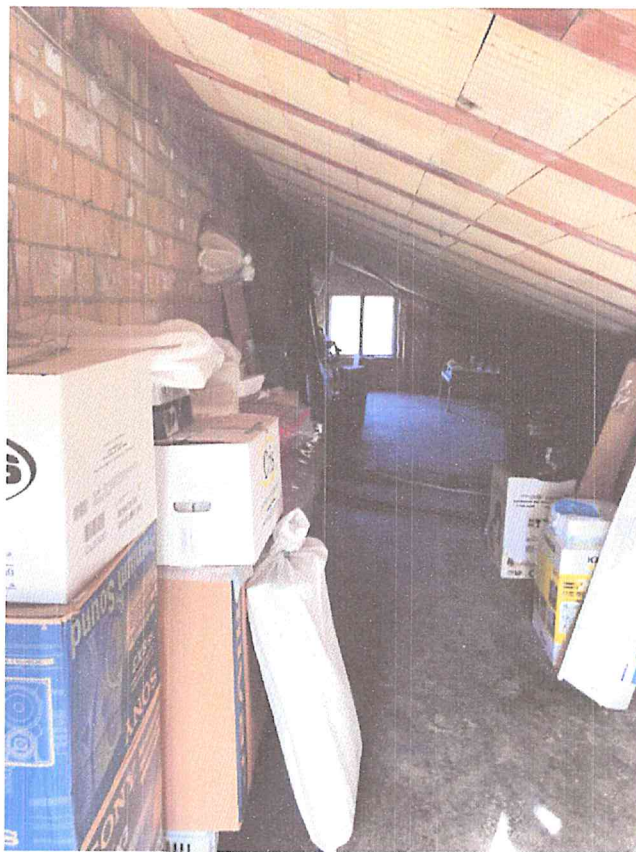
FOTO 9 – soffitta piano secondo/sottotetto
