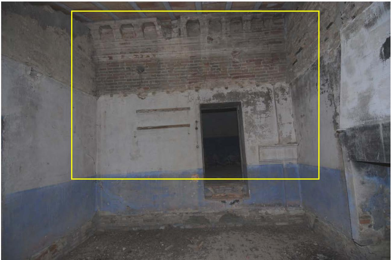
Foto 4 – Vecchio cornicione esterno presente all'interno del sottotetto
