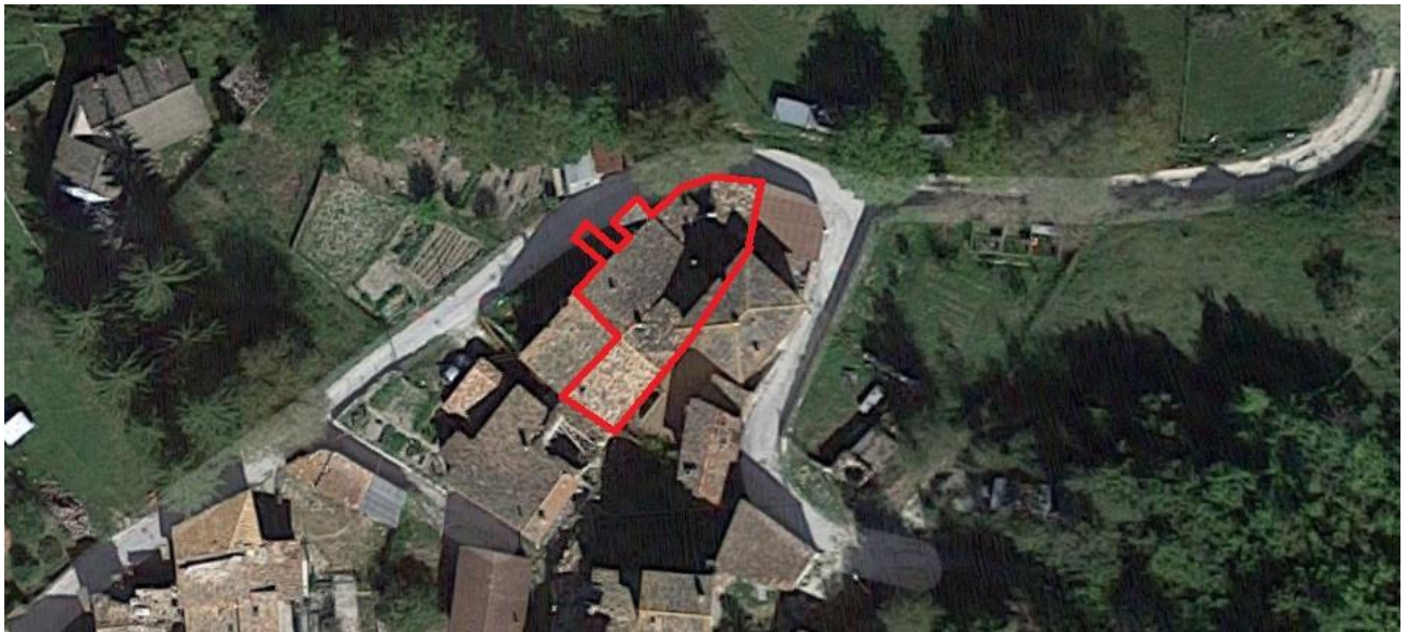
Foto aerea dell'aggregato
