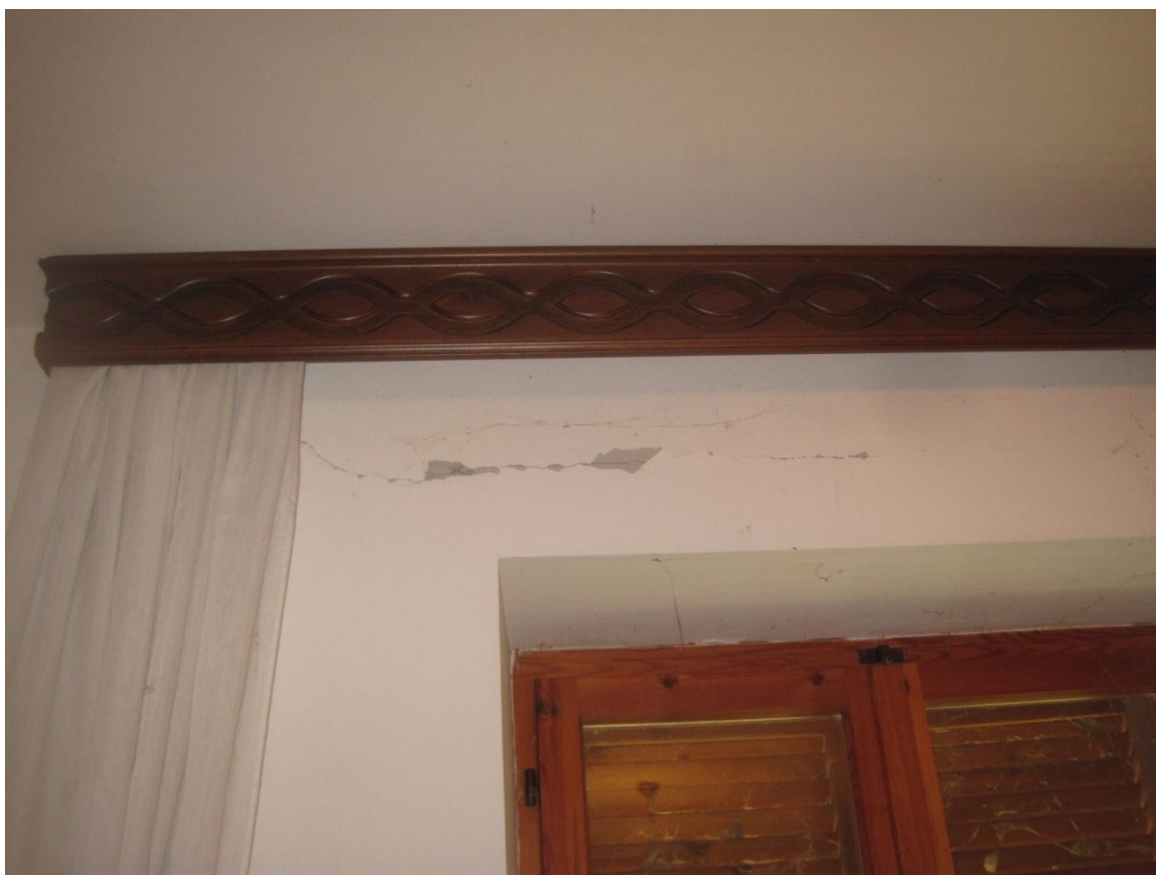
Muratura perimetrale Nord P1
