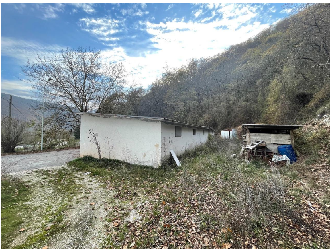
Foto 4 – Prospetti Nord e Est edificio garage.
