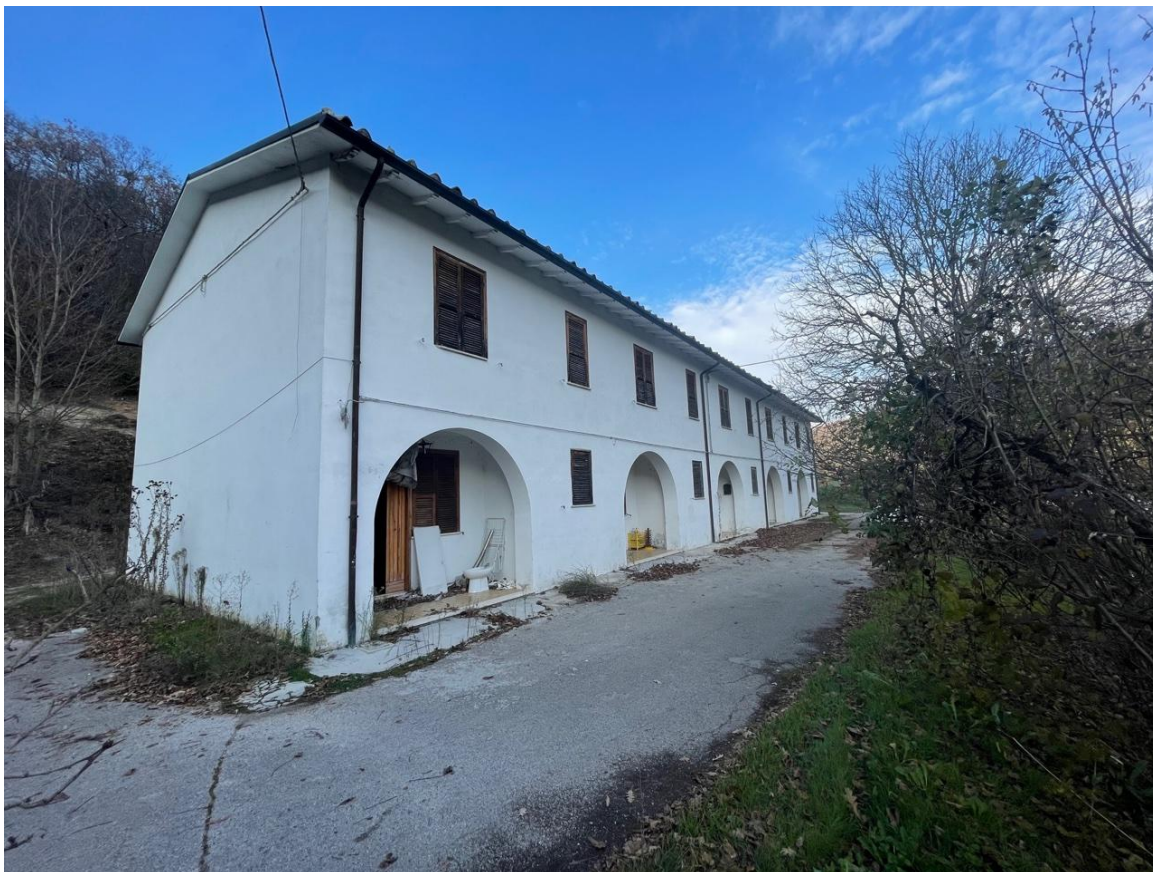
Foto 1 - Prospetto Sud edificio ad uso abitativo.
