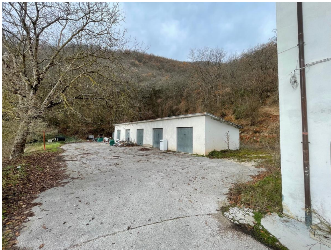
Foto 1 - Prospetti Sud - Ovest
