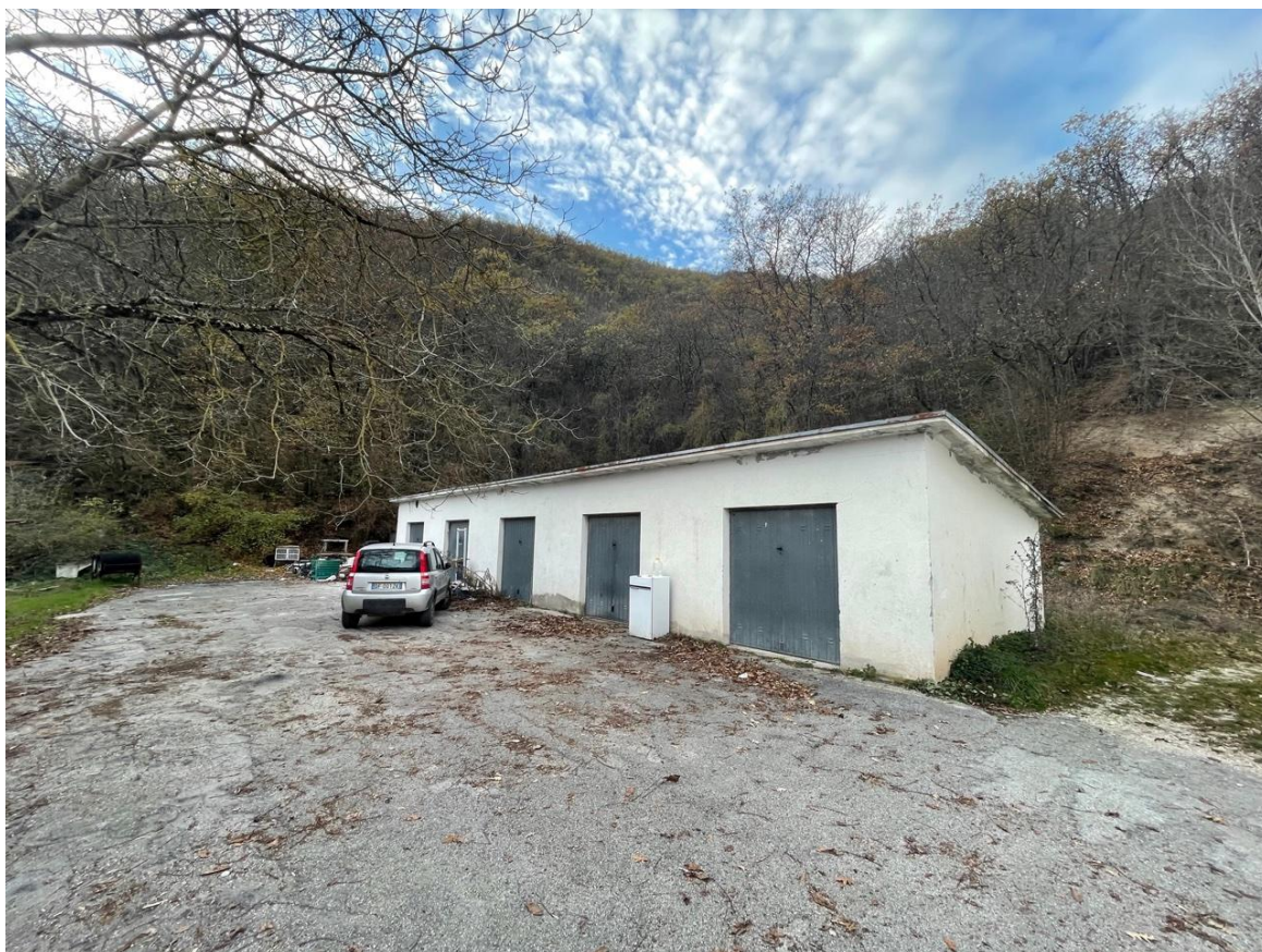
Foto 3 – Prospetto Sud edificio garage.
