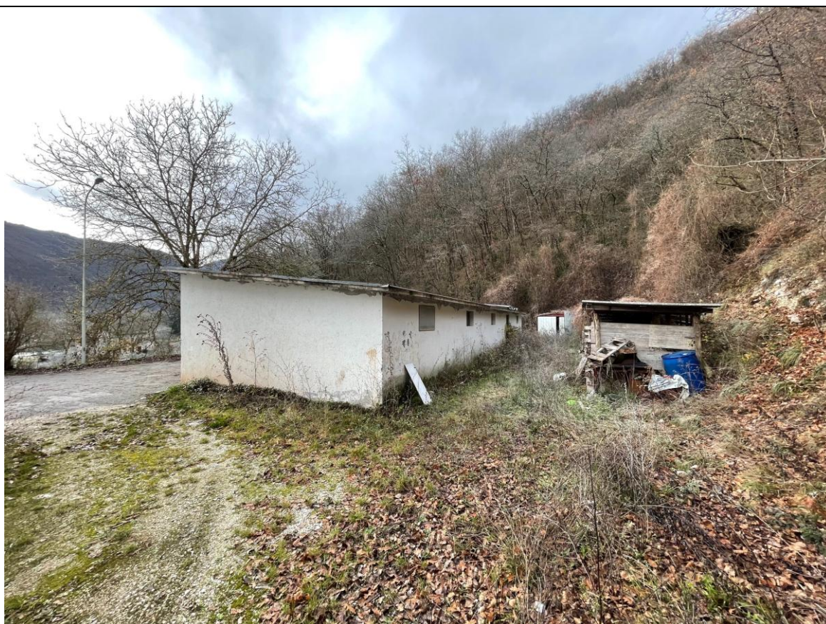
Foto 2 - Prospetti Nord - Est
