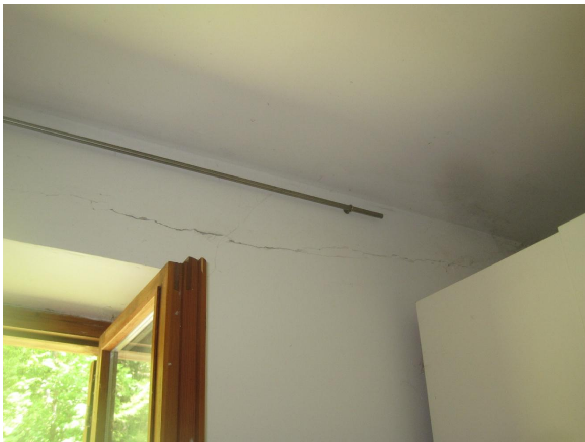
Muratura perimetrale Nord P1
