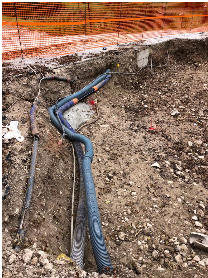
Foto 2 – Dettaglio dei sottoservizi (varie linee) spostati fuori dalla sagoma delle fondazioni come dal picchettamento eseguito dalla Ditta.
