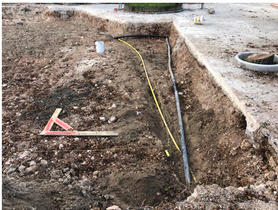
Foto 3 – Dettaglio dei sottoservizi (acquedotto) spostati fuori dalla sagoma delle fondazioni come dal picchettamento eseguito dalla Ditta.
