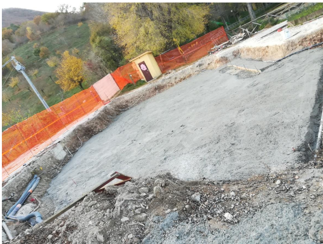
Foto 4 – Getto del magrone eseguito dalla Ditta dopo lo spostamento dei sottoservizi.
