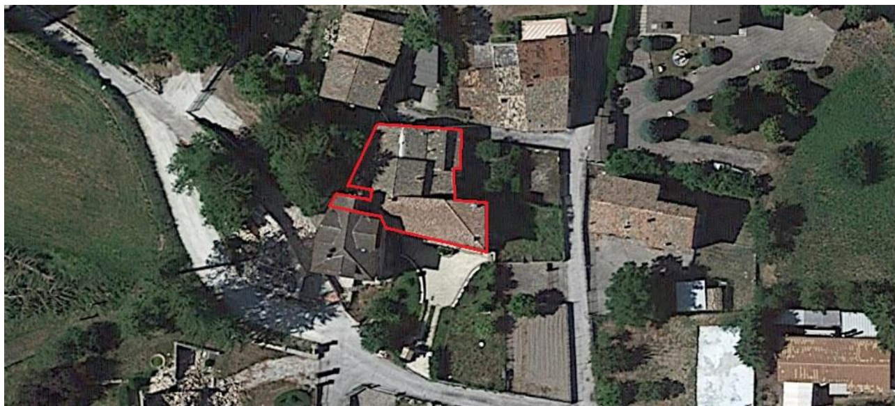
Foto aerea dell'aggregato
