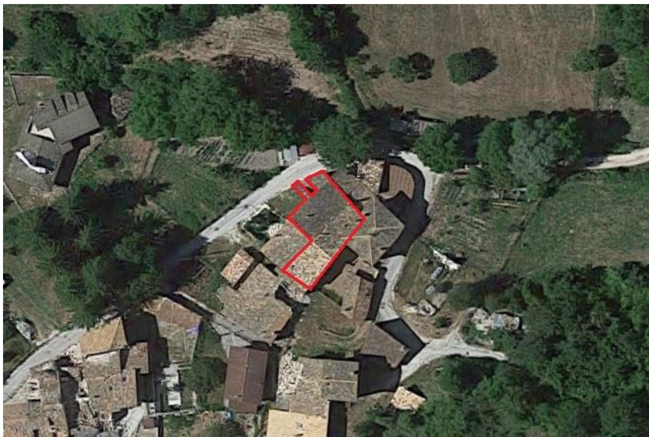
Foto aerea dell'aggregato
