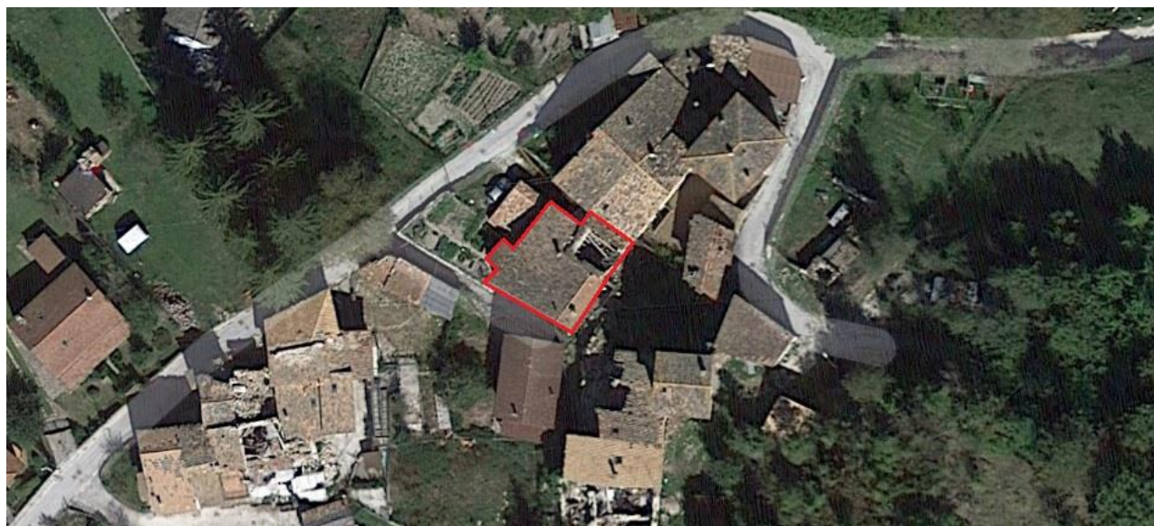
Foto aerea dell'aggregato
