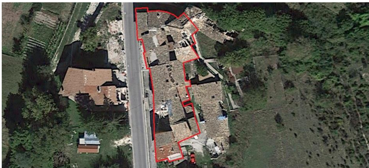
Foto aerea dell'aggregato
