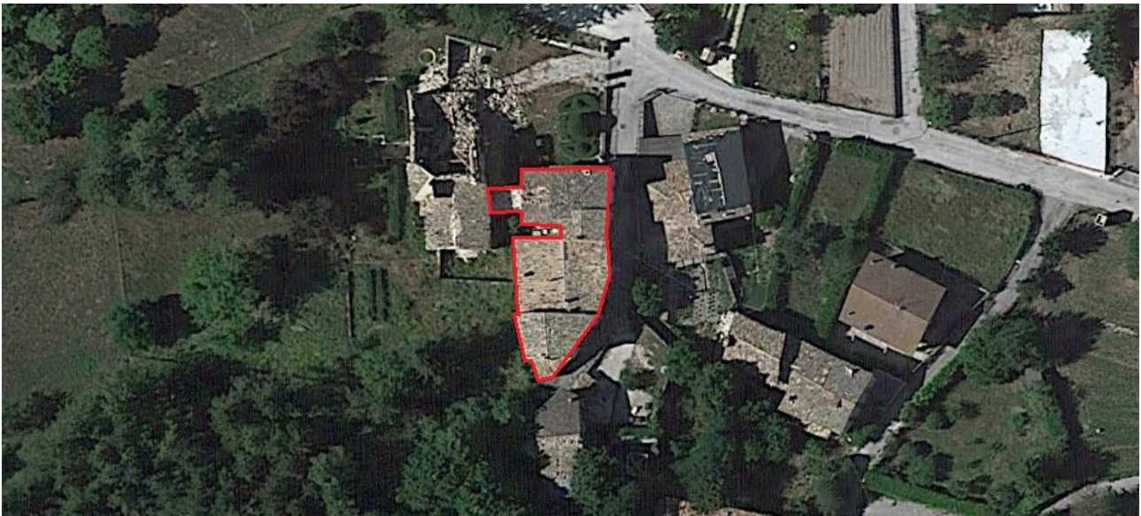
Foto aerea dell'aggregato
