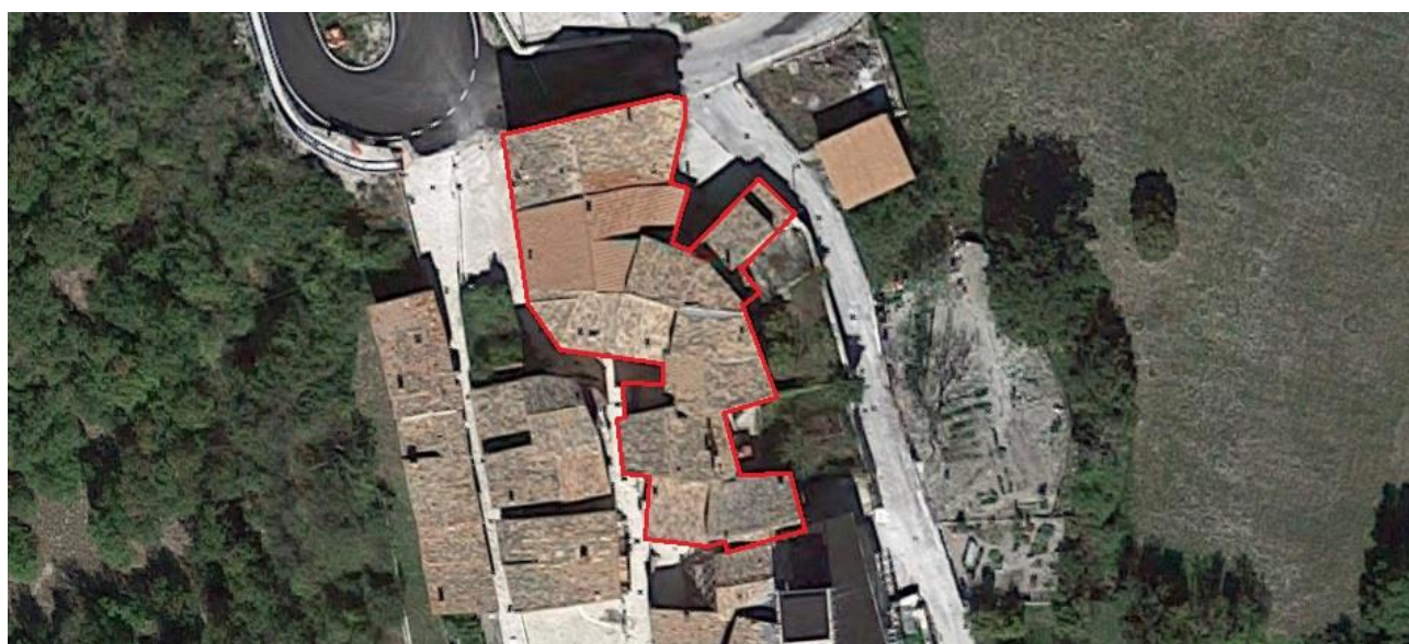
Foto aerea dell'aggregato
