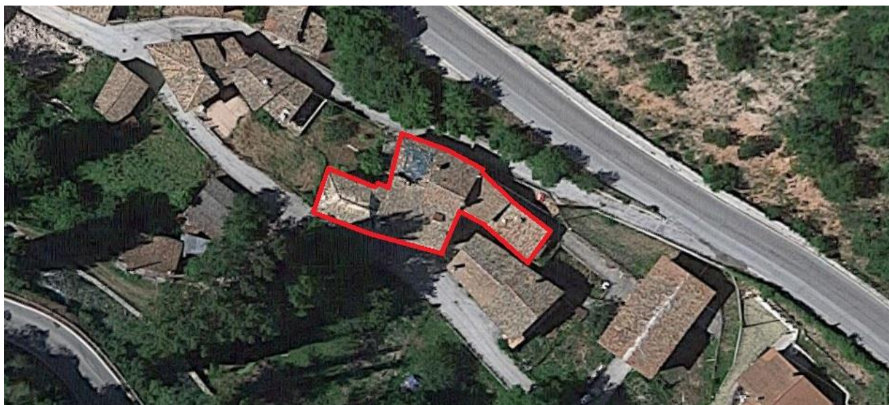
Foto aerea dell'aggregato
