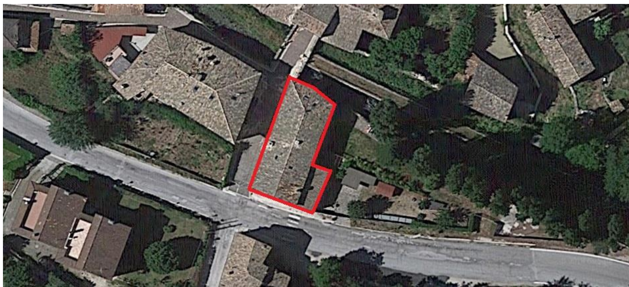
Foto aerea dell'aggregato
