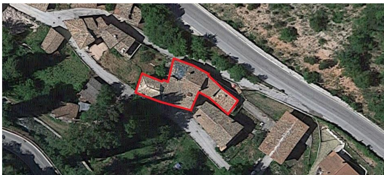
Foto aerea dell'aggregato
