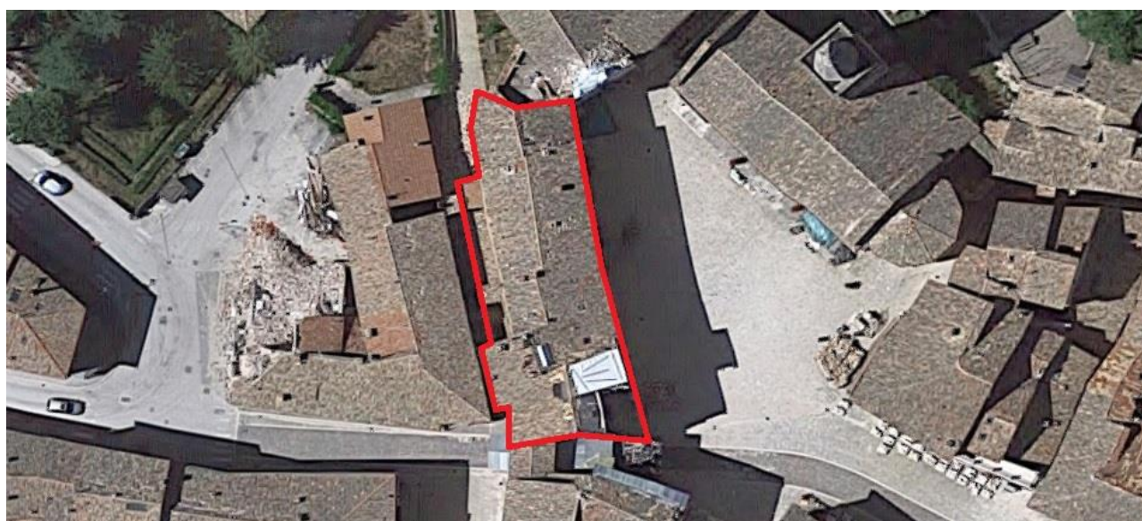
Foto aerea dell'aggregato
