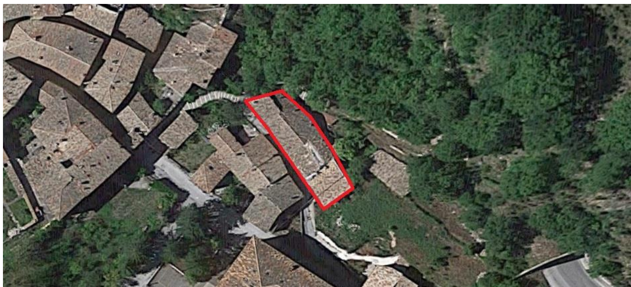
Foto aerea dell'aggregato
