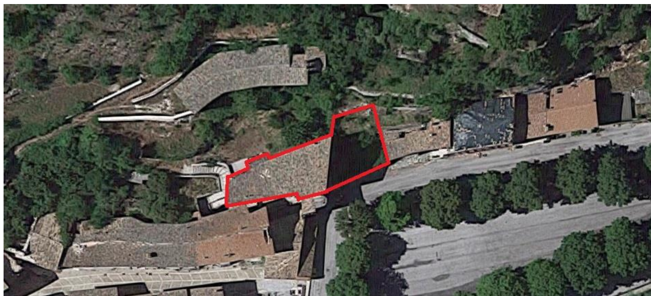
Foto aerea dell'aggregato
