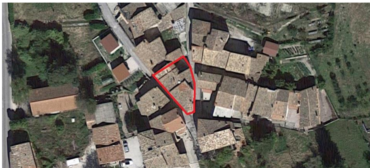
Foto aerea dell'aggregato
