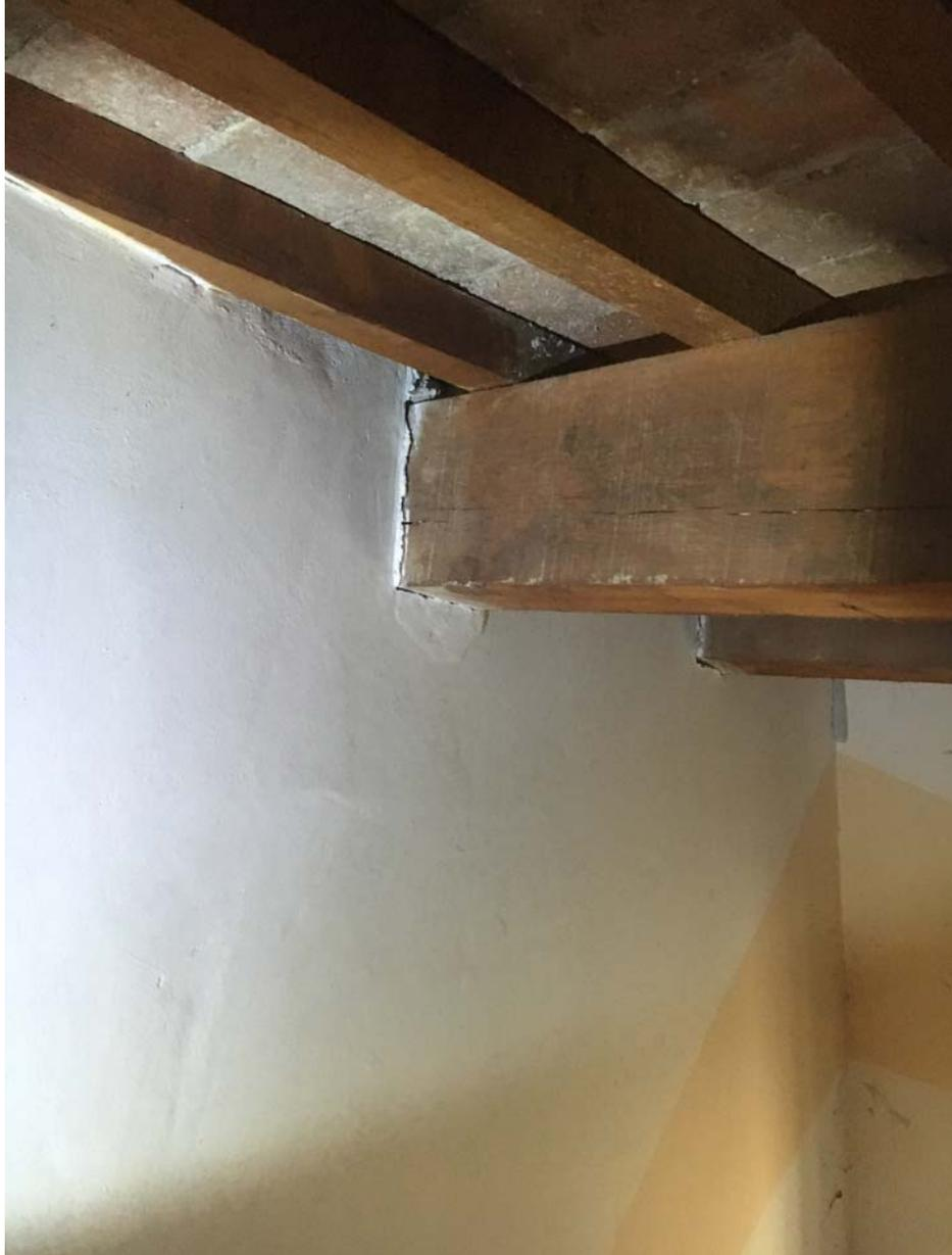
FOTO 51 MARTELLAMENTO MURO DI SPINA IN COPERTURA
