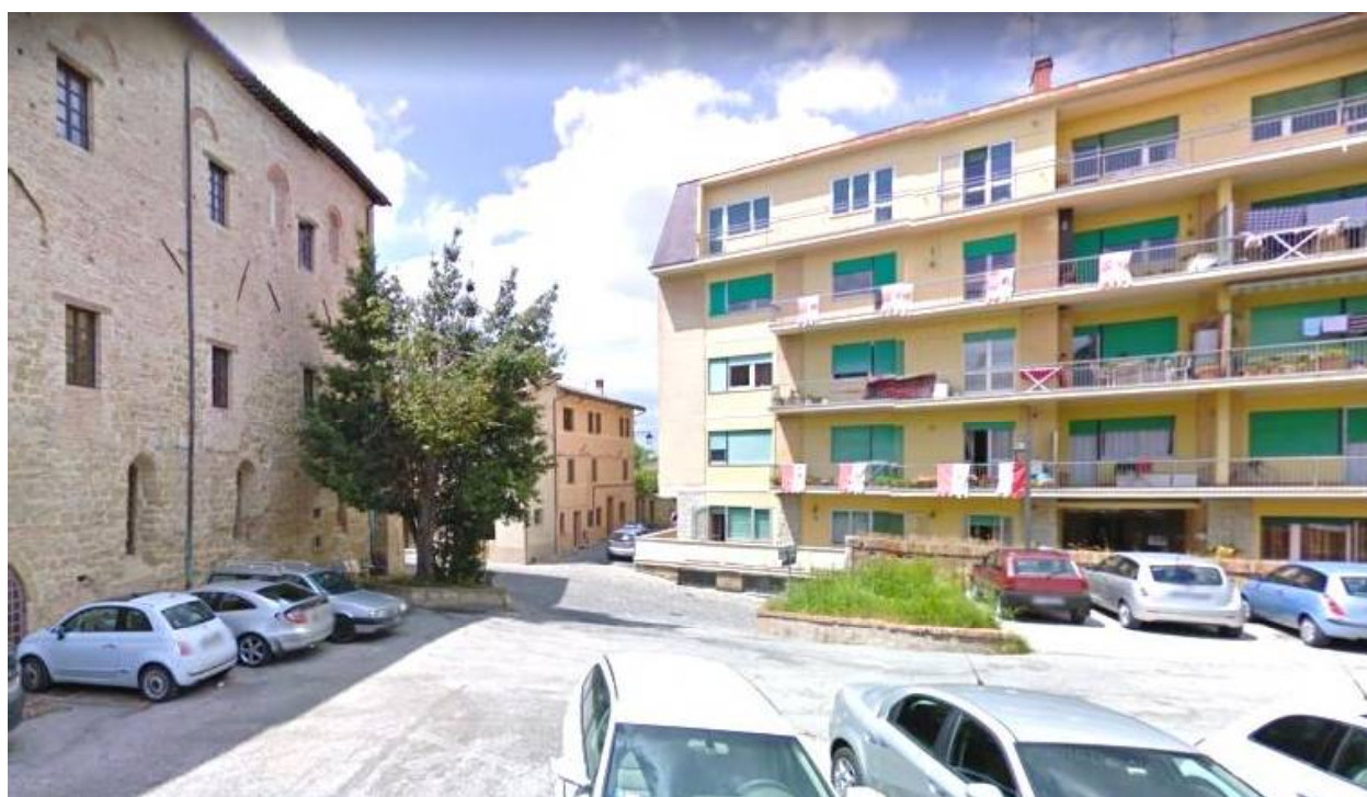
Vista dell'edificio dal parcheggio urbano a valle
