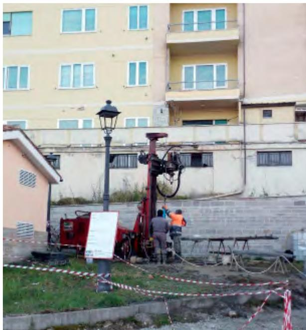
**Fig. 1: Postazione del sondaggio geognostico S1.**
