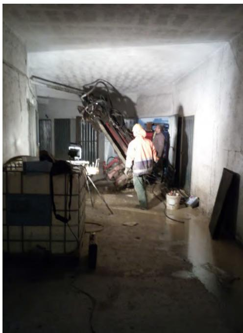
Fig. 2: Postazione del sondaggio geognostico S2.
