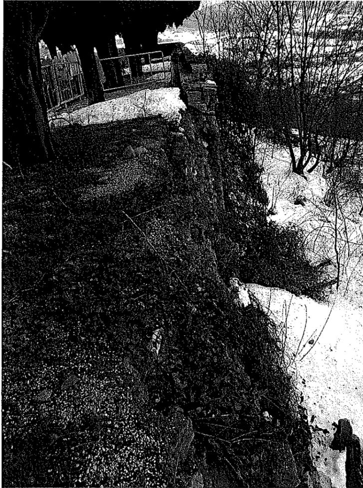
FOTO 12: MURO DI RECINZIONE E CHE TIENE IL TERRAPIENO CROLLATO
