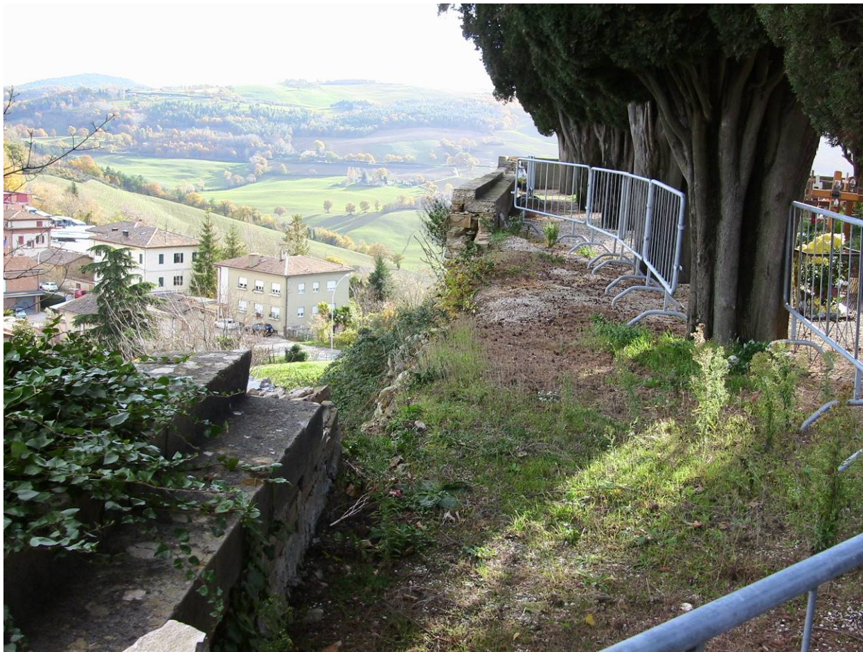
Foto 13 MURO DI RECINZIONE E DI CONTENIMENTO – PORZIONE COLLATA
