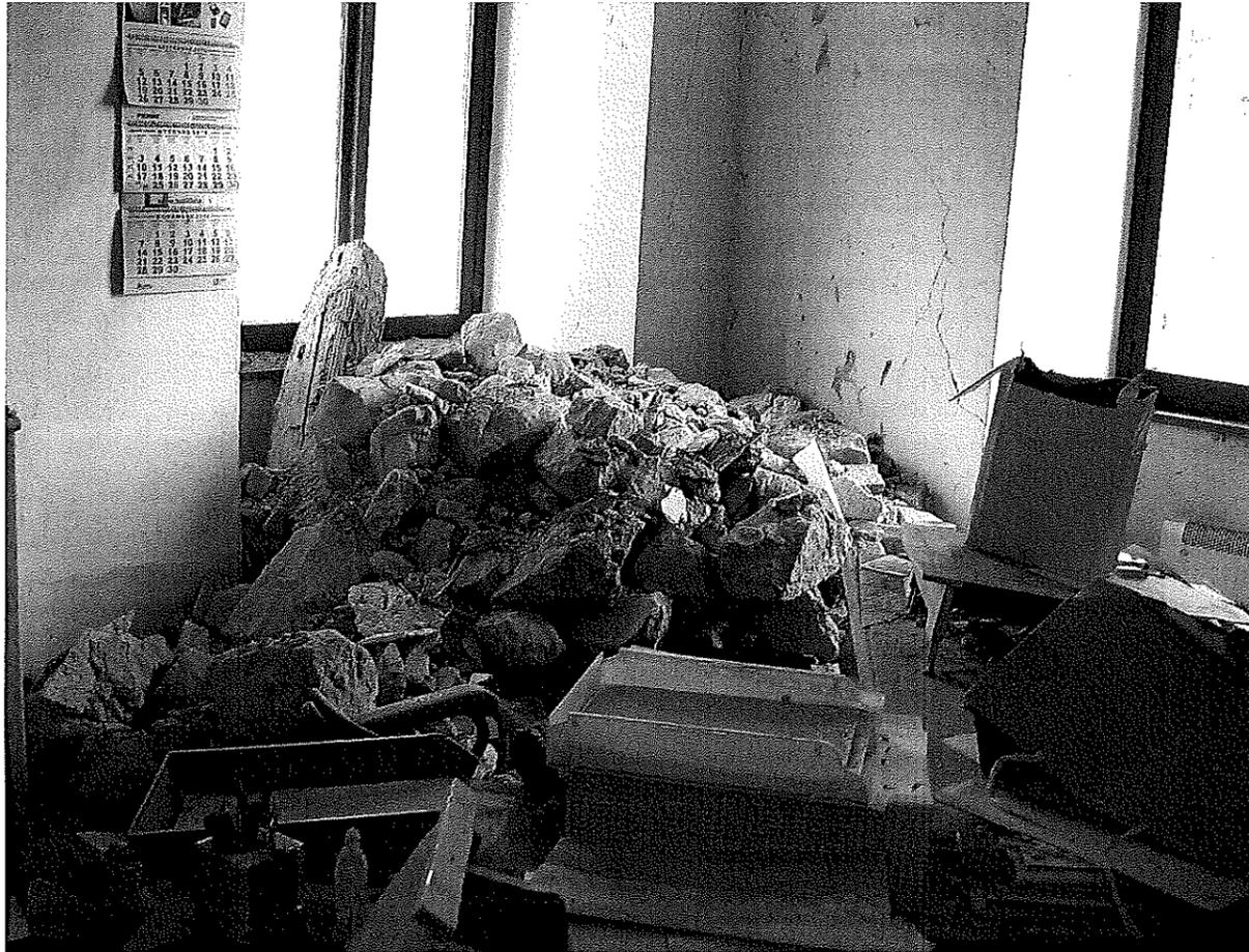
FOTO 3: EDIFICIO PRINCIPALE - PARTE INTERNA SEMPRE RIFERITO ALLO SPANCIAMENTO ESTERNO CON CROLLO DI PARTE DEL PARAMENTO MURARIO SOPRA LA SCRIVANIA
