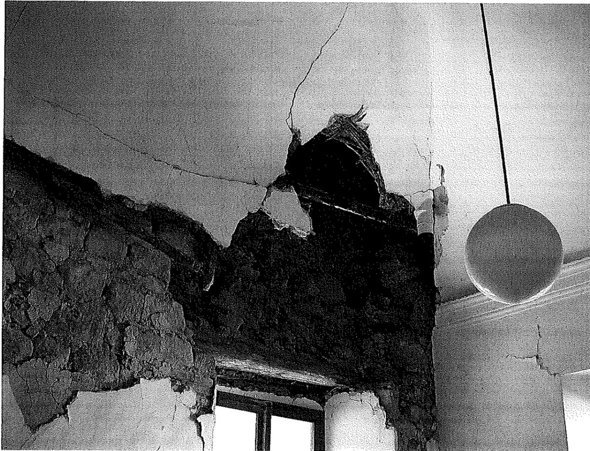
FOTO 2: EDIFICO PRINCIPALE - PARTICOLARE DEL MURO NELLA PARTE INTERNA IN CORRISPONDENZA DELLO SPANCIAMENTO ESTERNO
