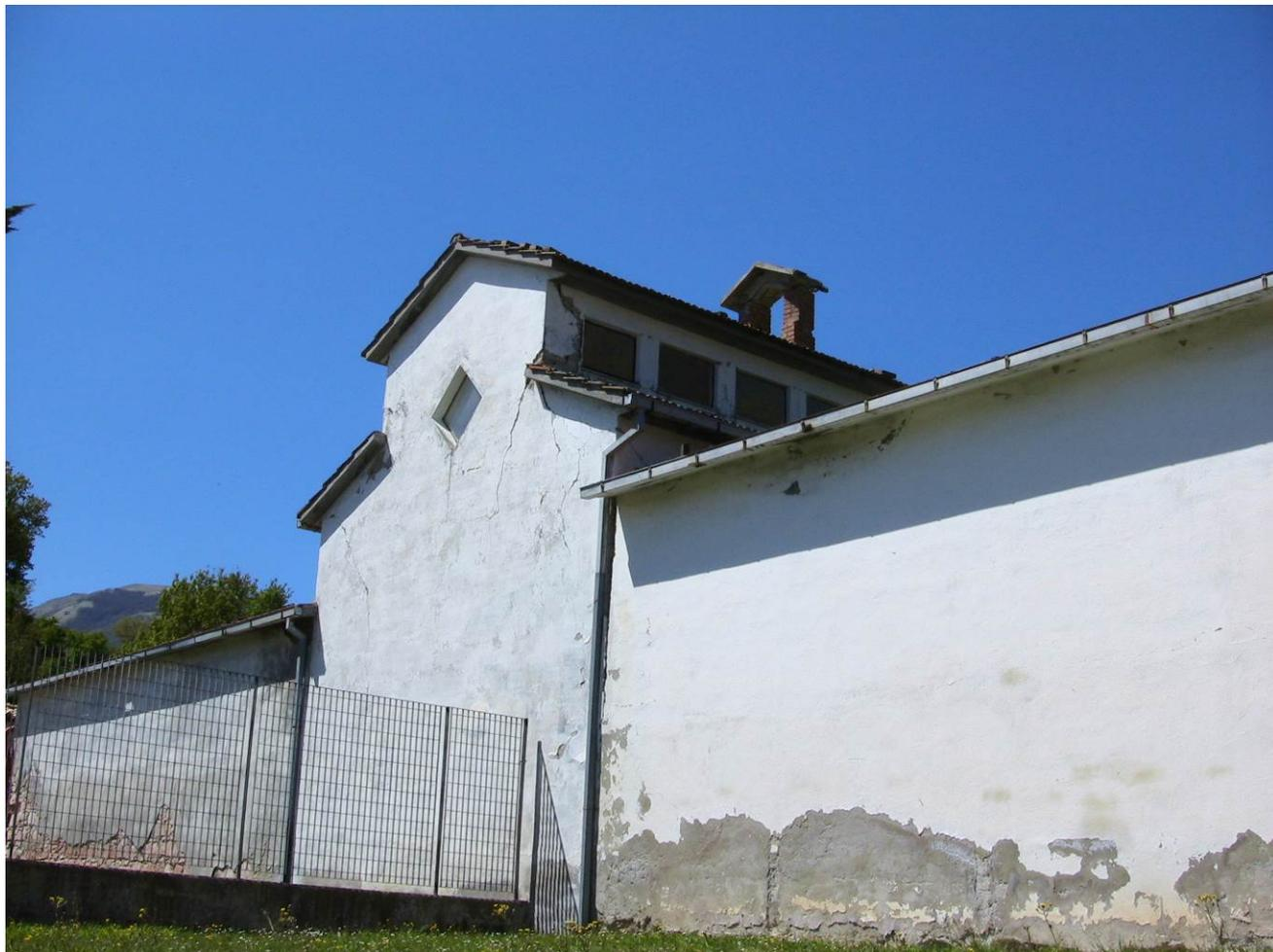
Foto 10 Lesioni sul lato posteriore della chiesetta/camera mortuaria
