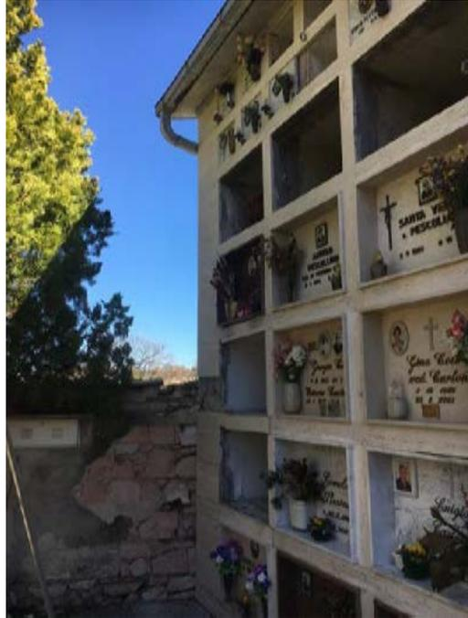
Foto 18 Rottura e distacco lastre di marmo su colombario
