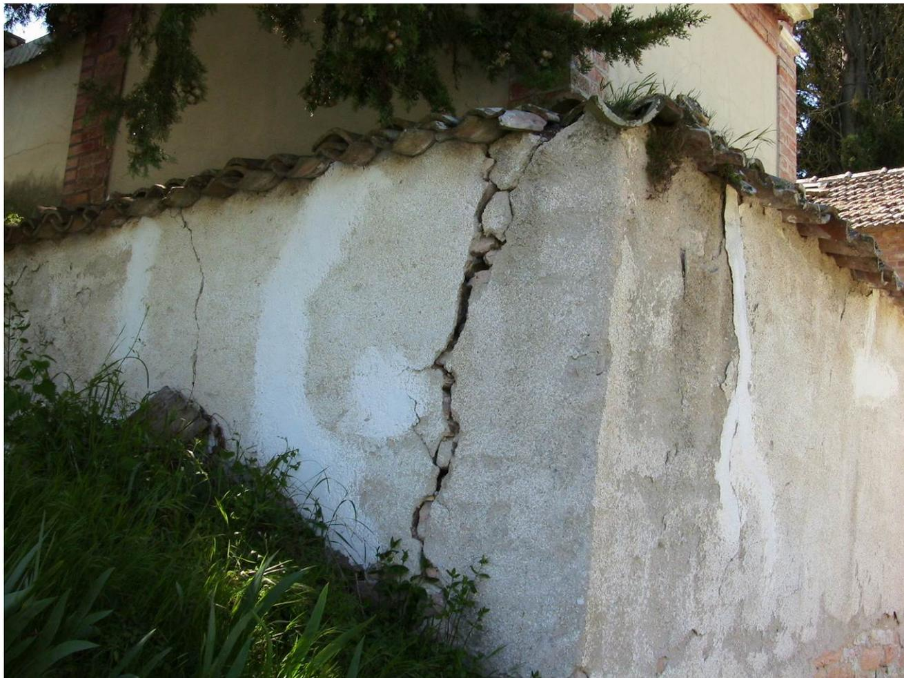
Foto 11 Muro di recinzione gravemente danneggiato nell'angolo Nord-Ovest
