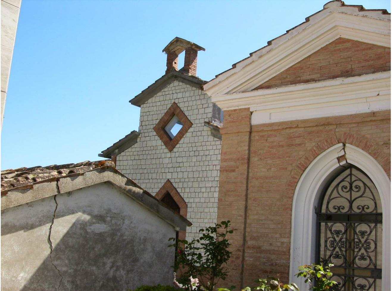
Foto 17 Vista delle due cappelline private gravemente danneggiate e sullo sfondo la chiesetta/camera mortuaria
