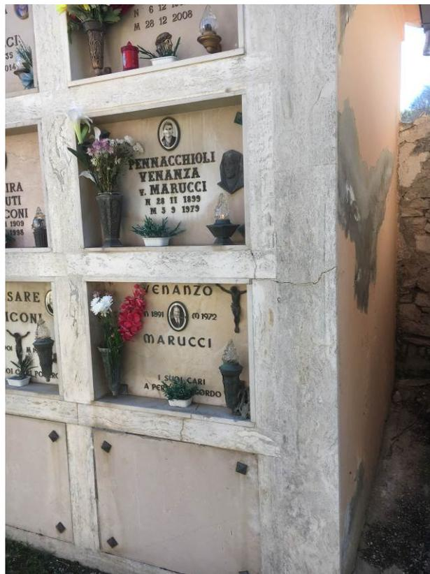
Foto 21 Rottura e distacco lastre di marmo su colombario
