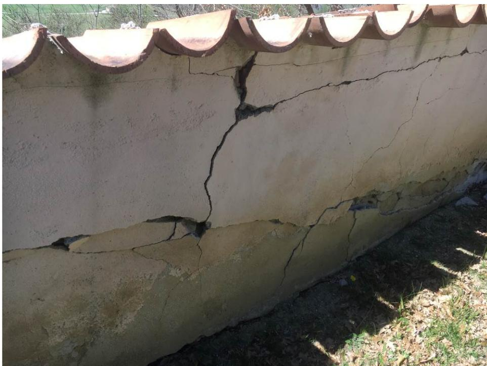
Foto 7 – Particolare danneggiamento muro di recinzione lato Ovest
