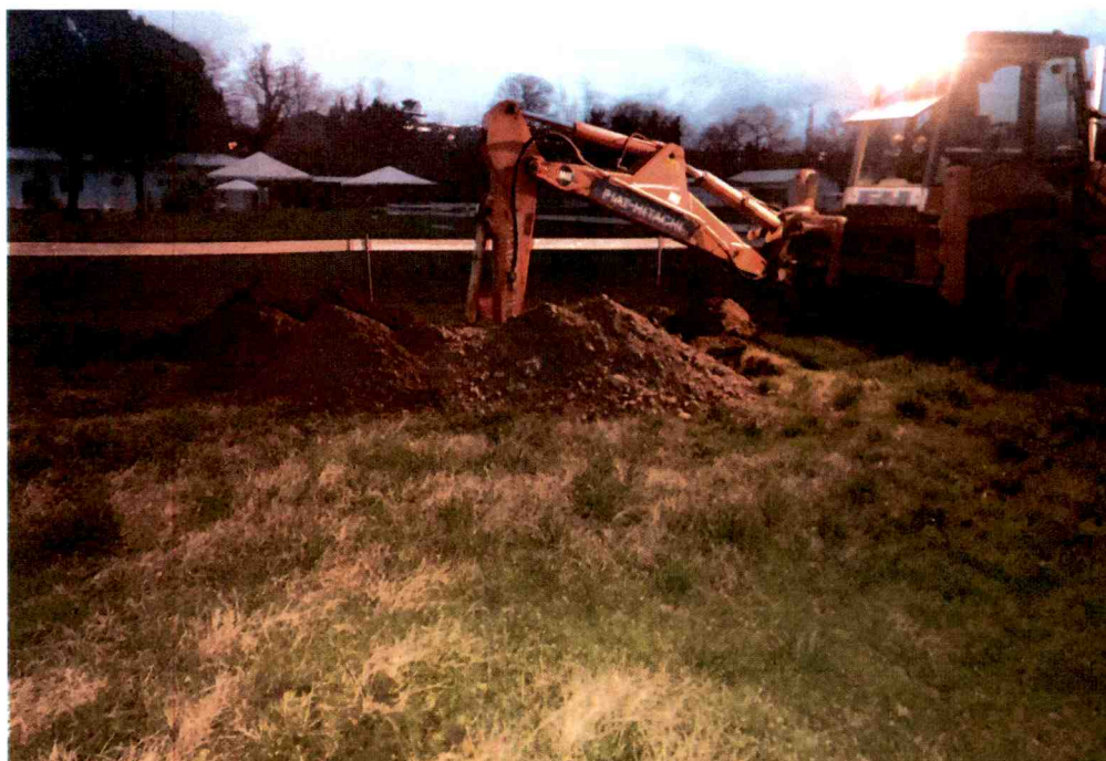
FOTO 3: fasi di esecuzione del saggio n°2 nell'area dell'elisuperficie.
