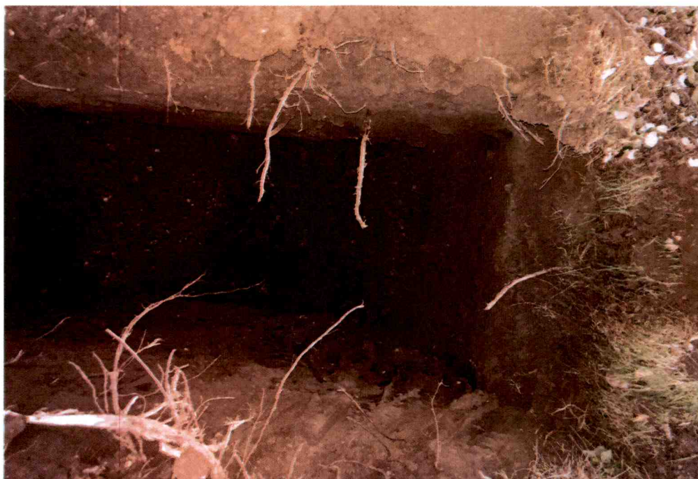
FOTO 2: particolare del primo saggio, è visibile lo spessore di limo sabbioso-ghiaioso sopra le ghiaie presenti sul fondo foro.
