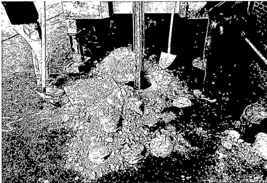
Foto 2: fase di esecuzione del sondaggio sono visibili i terreni intercettati.
