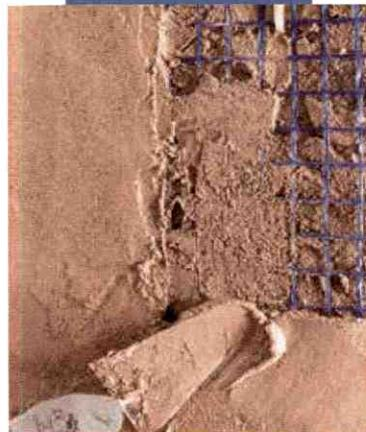
Applicazione del secondo strato di MapeWall Intonaca & Rinforza
