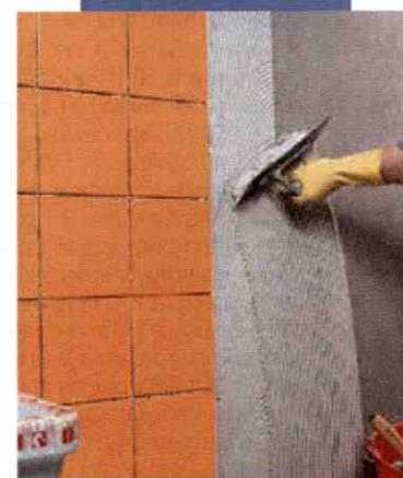
Incollaggio di rivestimento ceramico su MapeWall Intonaca & Rinforza
