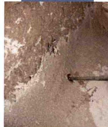
Inserimento di MapeWrap FIOCCO nel foro
